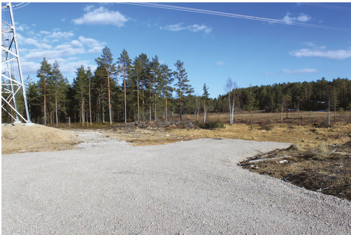
Eksisterende bilveg slutter ved Statnetts 420kV linje. Videreføring av denne vegen bygges i kanten mellom skog og myr ca midt i bildet.
