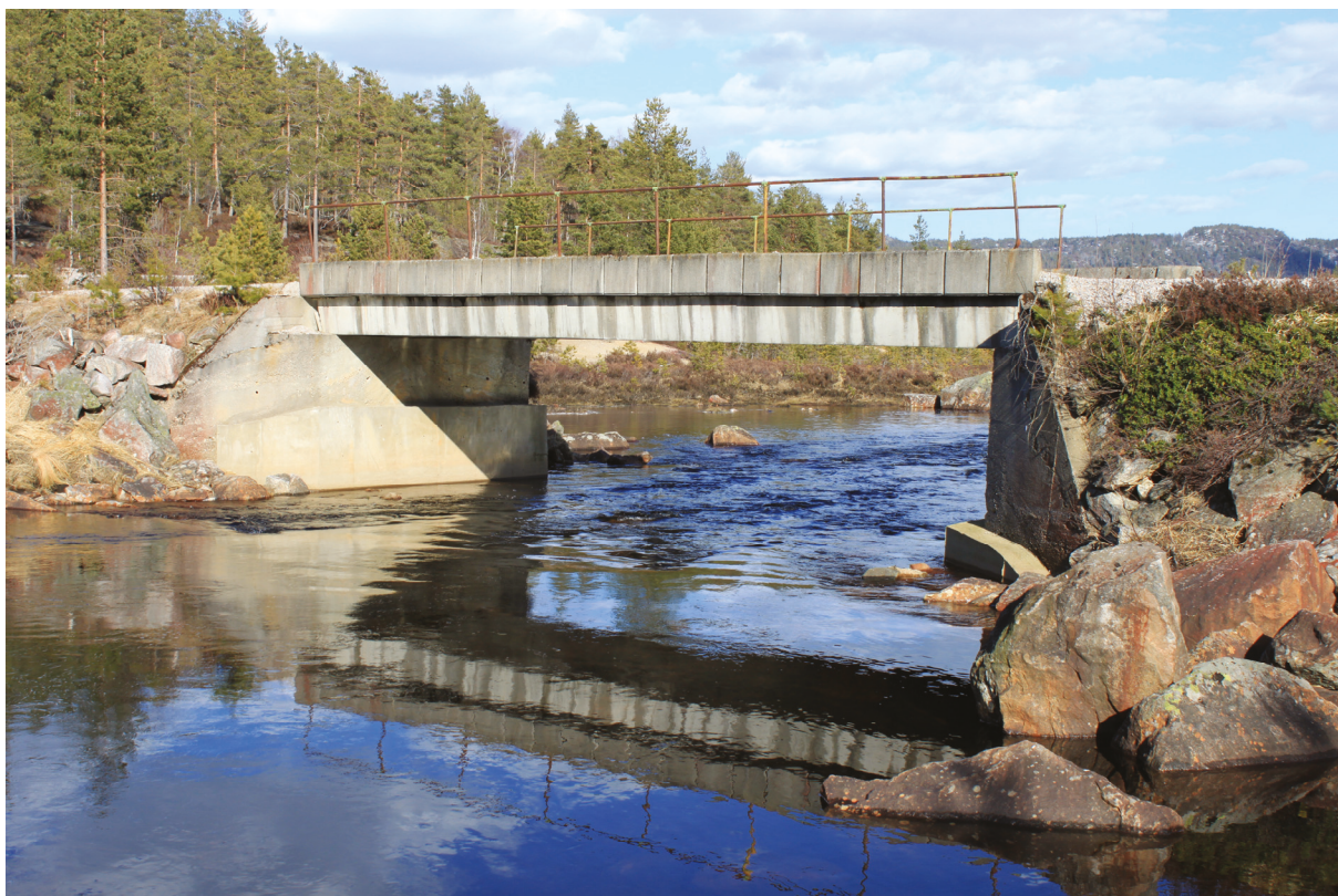
Vegen krysser Høgelilona like nedenfor Høgelifossen. På bildet er det 2,1 meter fra vannspeilet og opp til broens master.
