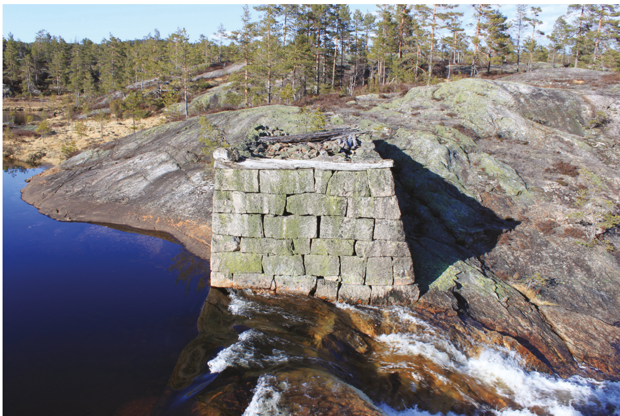
Stopstemmens høyde er ca 3 m. Tykkelse i toppen 3,9 m. Åpningen er 10 m bred.
