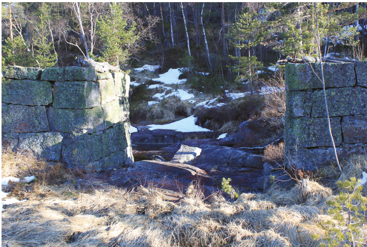
Stopstemmen har et sideutløp. Dette ligger høyere enn hovedutløpet og vil bare være i bruk ved større vannføringer.
