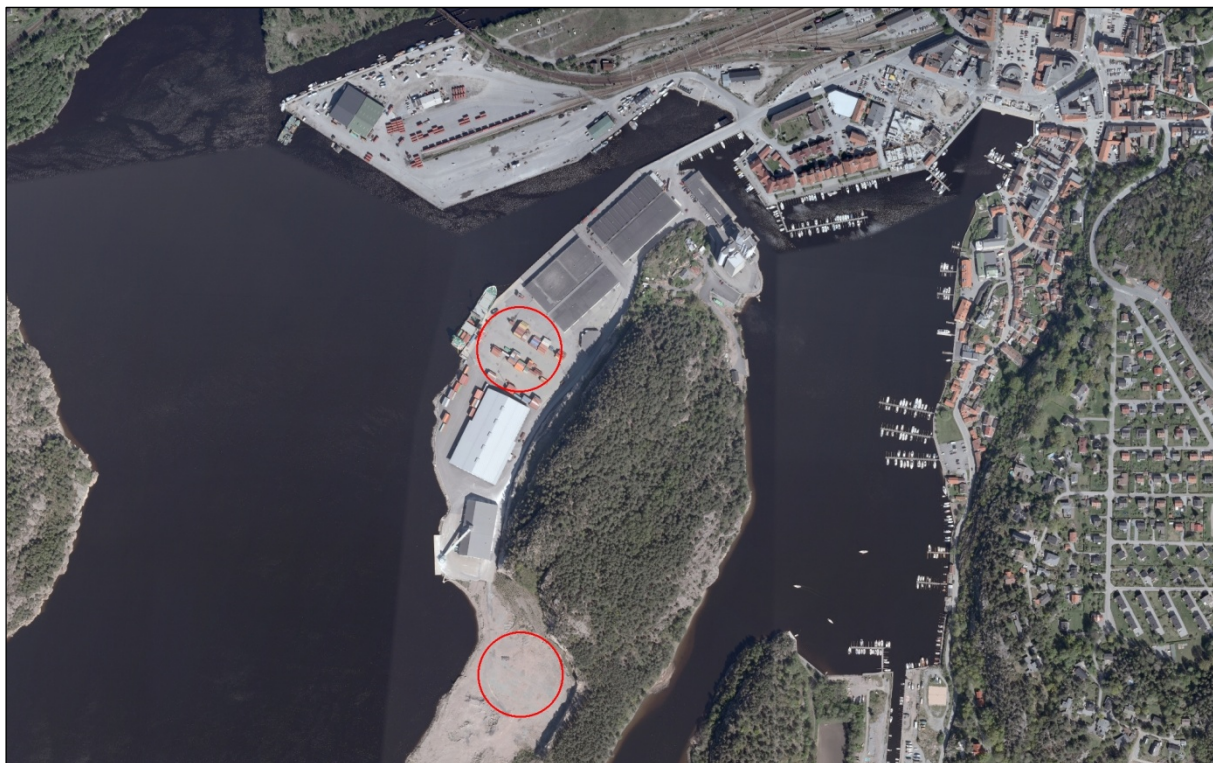
Figur 7. Mulig areal for mellomlagring av turbinmoduler. Kilde: NorgeiBilder.
