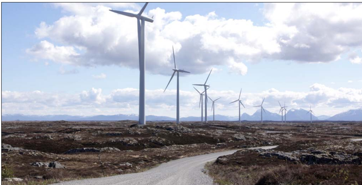
Figur 3. Smøla vindkraftverk med internveger og vindturbiner. Vegene har normalt en bredde på ca. 5 m og grusdekke. Adkomst- og internvegene på Kjølen vindpark vil også kunne brukes av grunneierne i forbindelse med skogsdrift.
