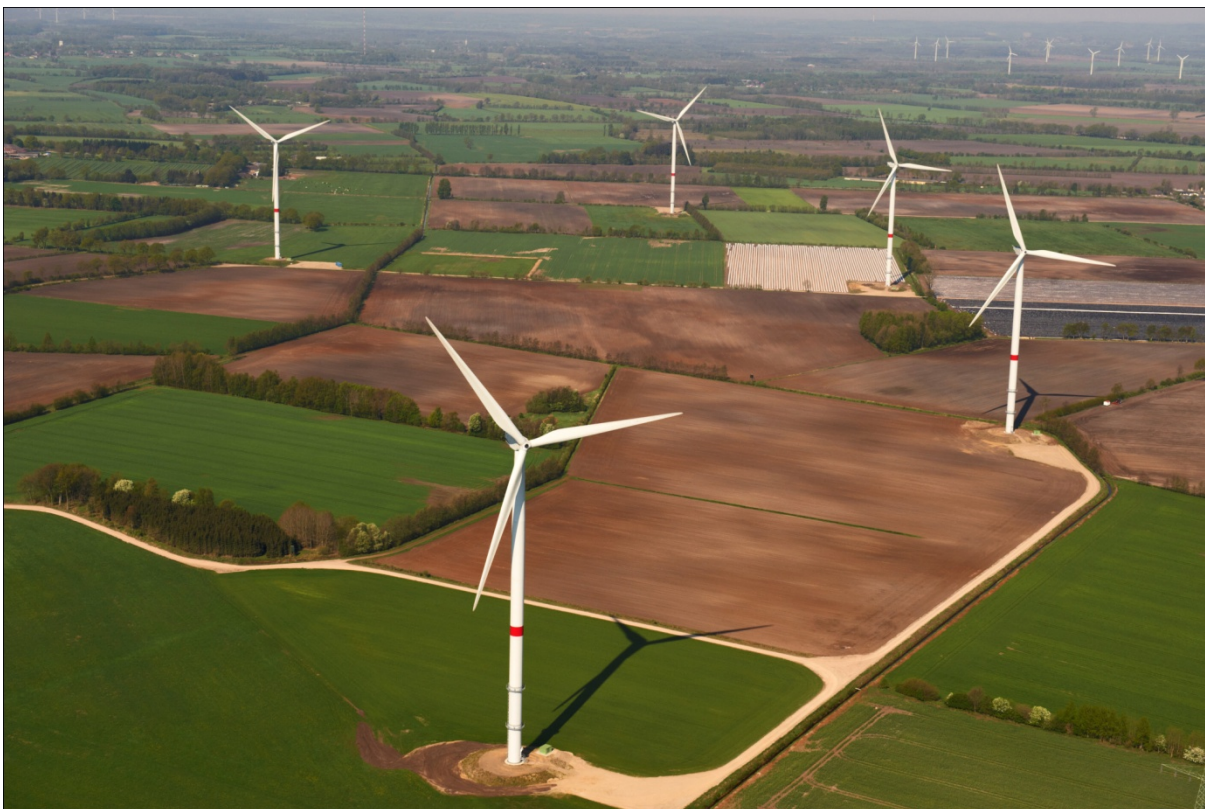
Figur 2. Nordex-turbiner i et tysk kulturlandskap. Et internt nettverk av veger og jordkabler legges mellom turbinene og trafo/driftsbygning sentralt i området.
