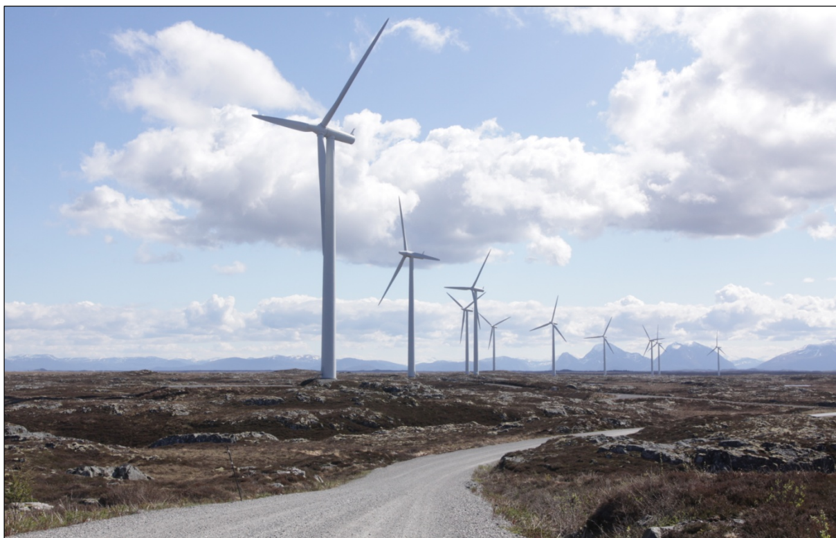
Figur 3. Smøla vindkraftverk med internveger og vindturbiner. Vegene har normalt en bredde på ca. 5 m og grusdekke. For Kjølen vindkraftverk vil adkomst- og internvegene kunne brukes av grunneierne i forbindelse med skogsdrift.
