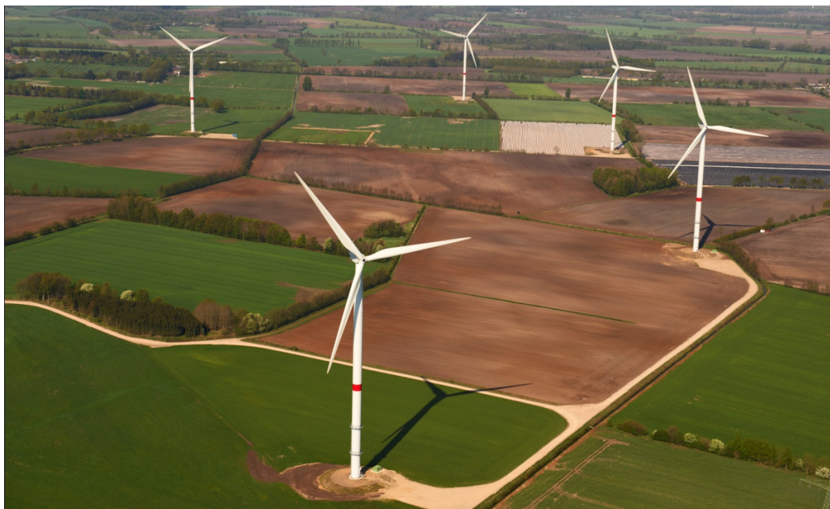
Figur 2-2. Nordex-turbiner i et tysk kulturlandskap. Et internt nettverk av veier og jordkabler legges mellom turbinene og trafo/driftsbygning sentralt i området.
