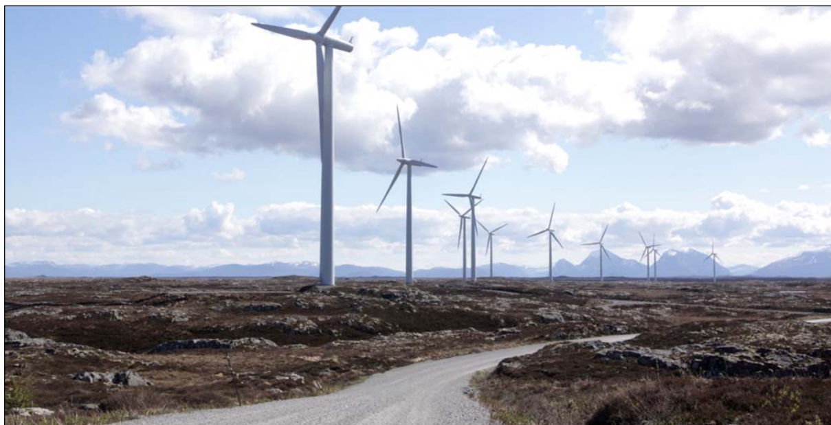
Figur 2-3. Smøla vindkraftverk med internveier og vindturbiner. Veiene har normalt en bredde på ca. 5 m og grusdekke. Adkomst- og internveiene på Kjølen vindpark vil også kunne brukes av grunneierne i forbindelse med skogsdrift.
