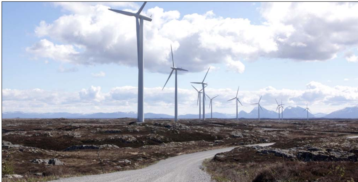
Figur 4. Smøla vindkraftverk med internveger og vindturbiner. Vegene har normalt en bredde på ca. 5 m og grusdekke. Adkomst- og internvegene på Kjølen vindpark vil også kunne brukes av grunneierne i forbindelse med skogsdrift.
