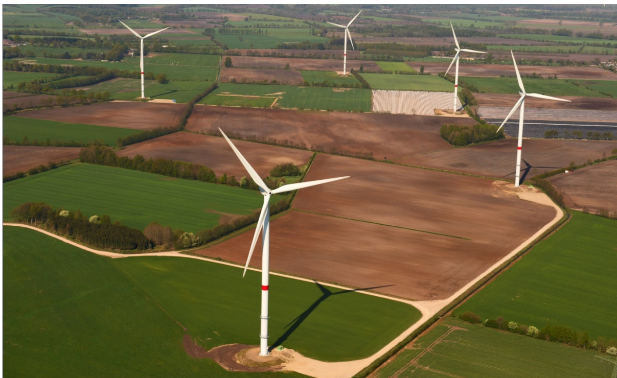
Figur 3. Nordex-turbiner i et tysk kulturlandskap. Et internt nettverk av veger og jordkabler legges mellom turbinene og trafo/driftsbygning sentralt i området.
