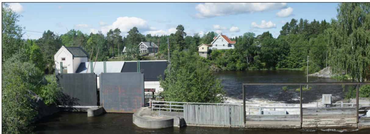
Bilde 17. Begrenset synlighet fra Strømsfoss. Nærværet av andre inngrep gjør Vindkraftverket mindre iøyenfallende, vist ved alternativ B.
