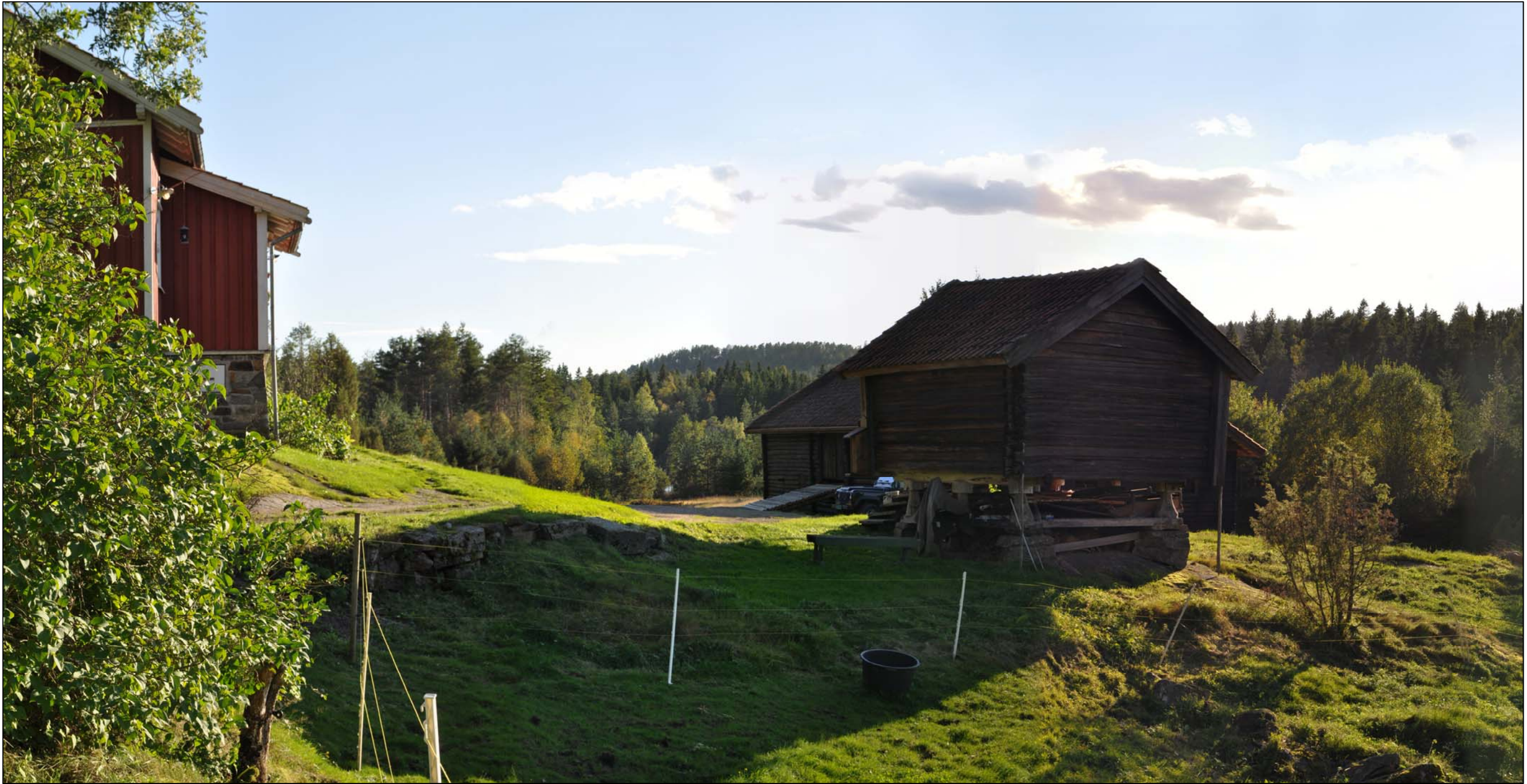
Bilde fra Bøensætre, ingen vindturbiner blir synlige uansett utbyggingsalternativ.
