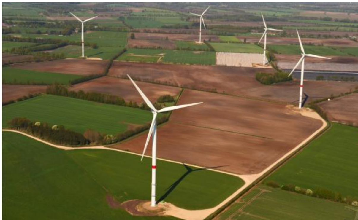
Figur 2. Nordex-turbiner i et tysk kulturlandskap. Et internt nettverk av vegger og jordkabler legges mellom turbinene og trafo/driftsbygning sentralt i området.
