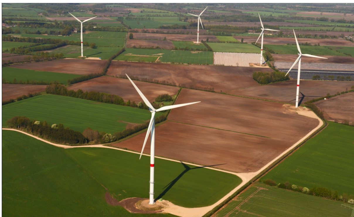
Figur 2. Nordex-turbiner i et tysk kulturlandskap. Et internt nettverk av veier og jordkabler legges mellom turbinene og trafo/driftsbygning sentralt i området.
