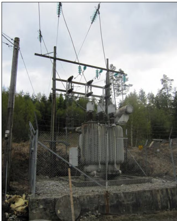
Figur 5. Foto til venstre. Eksisterende 15 MVA autotrafo i Brekke (Fra 1942 med noe usikker tilstand).
