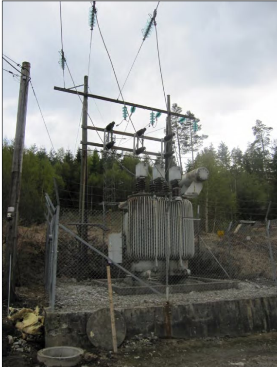
Figur 16. Dagens 48/48 kV trafo. (HN) Utendørsanlegg
