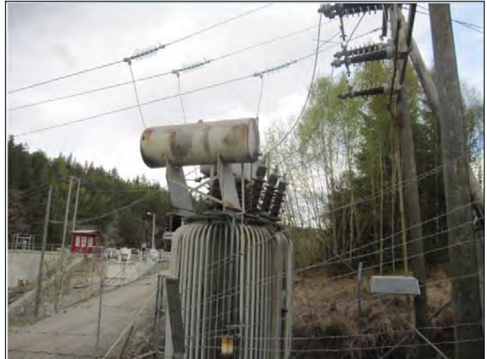
Figur 16. Dagens 48/48 kV trafo. (HN) Utendørsanlegg
