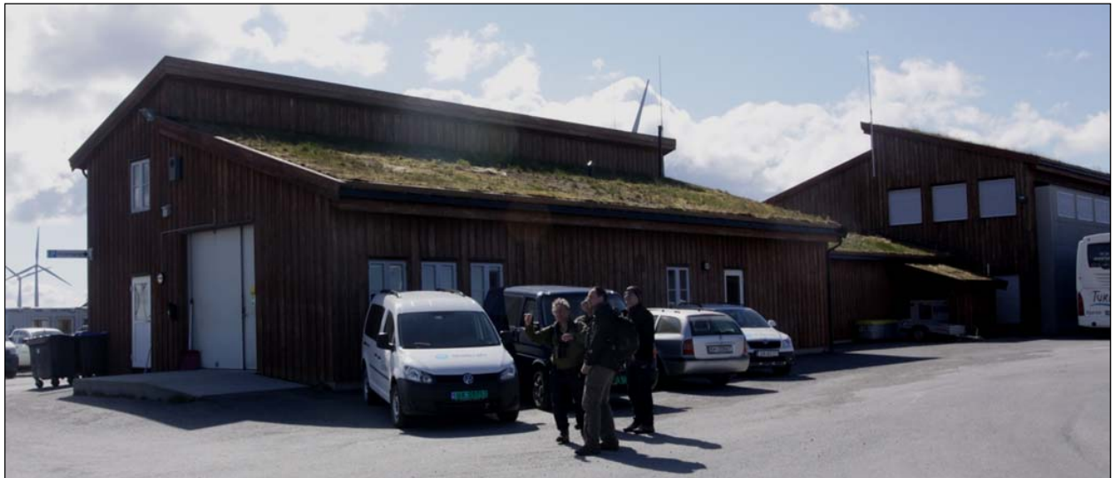
Figur 10. Transformatorstasjon (venstre) og servicebygg (høyre) i Smøla vindpark.
