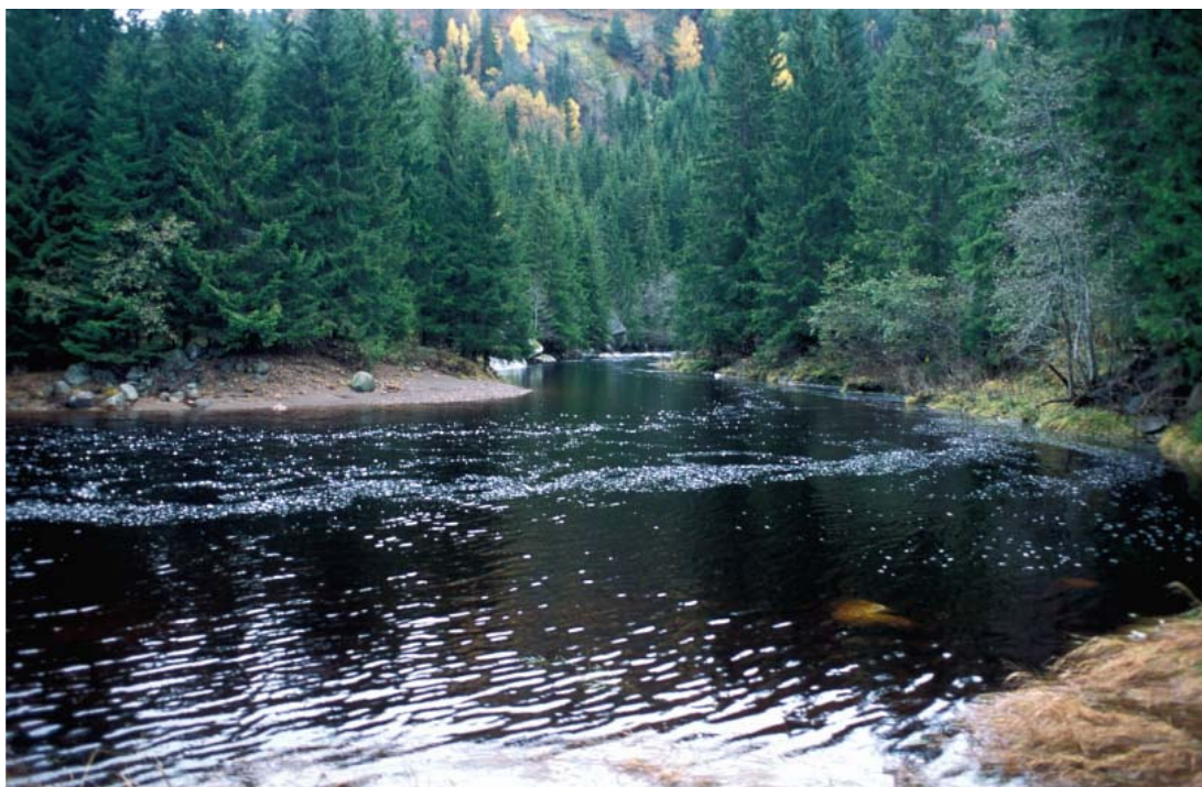
Figur 16 Bildet er fra Storelva ved Svarthull. Her gjør elva en skarp sving og danner en kulp som er synlig fra veien. På lav vannføring er kulpen langt mindre og om en ønsker å ha en markert kulp her er det mulig å bygge en terskel i utløpet av kulpen.
