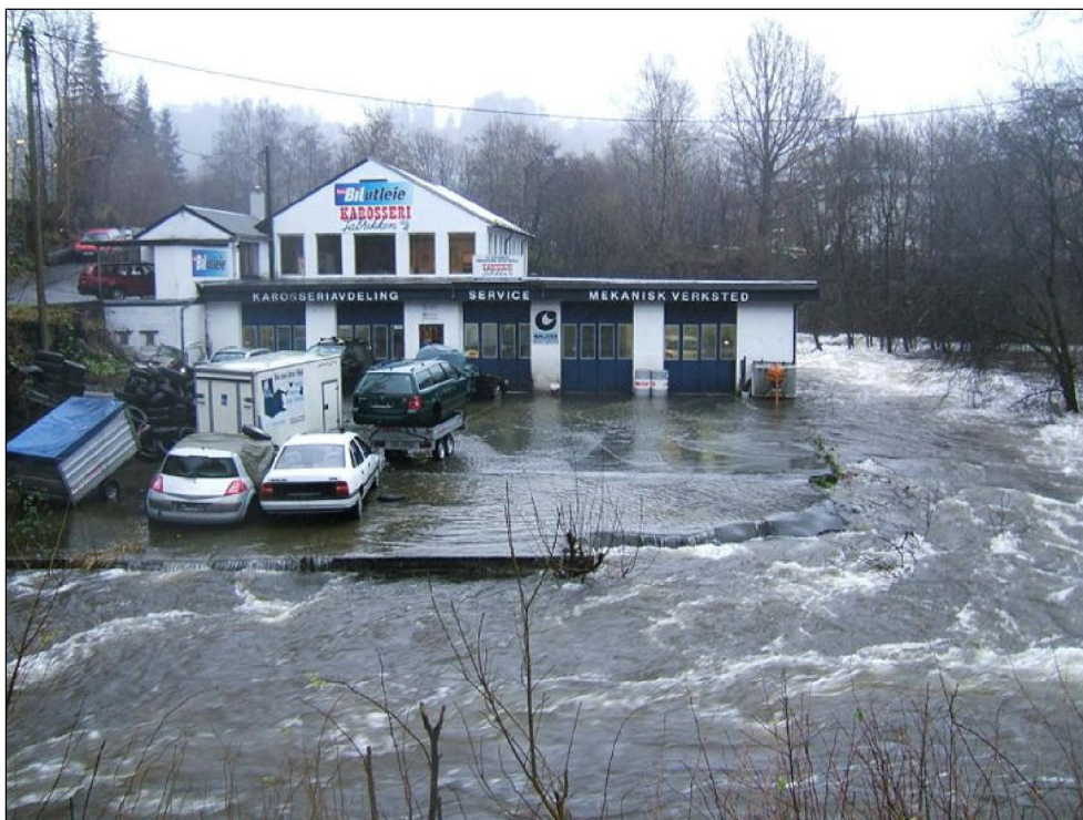
Foto: Store vannmasser i Nesttunelven like ved Skjoldskiftet ifm. flom i elven høsten 2005.
