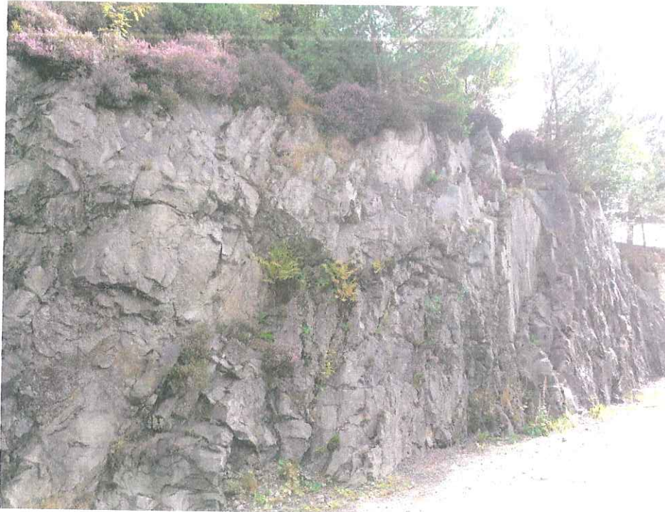
Figur 4. Vegskjæring nær myrområdet (bildet er tatt mot SØ). Det er til dels stor oppsprekningsgrad i dagfjellet her. Under dagfjellssonen er det forventet moderat oppsprekningsgrad.
