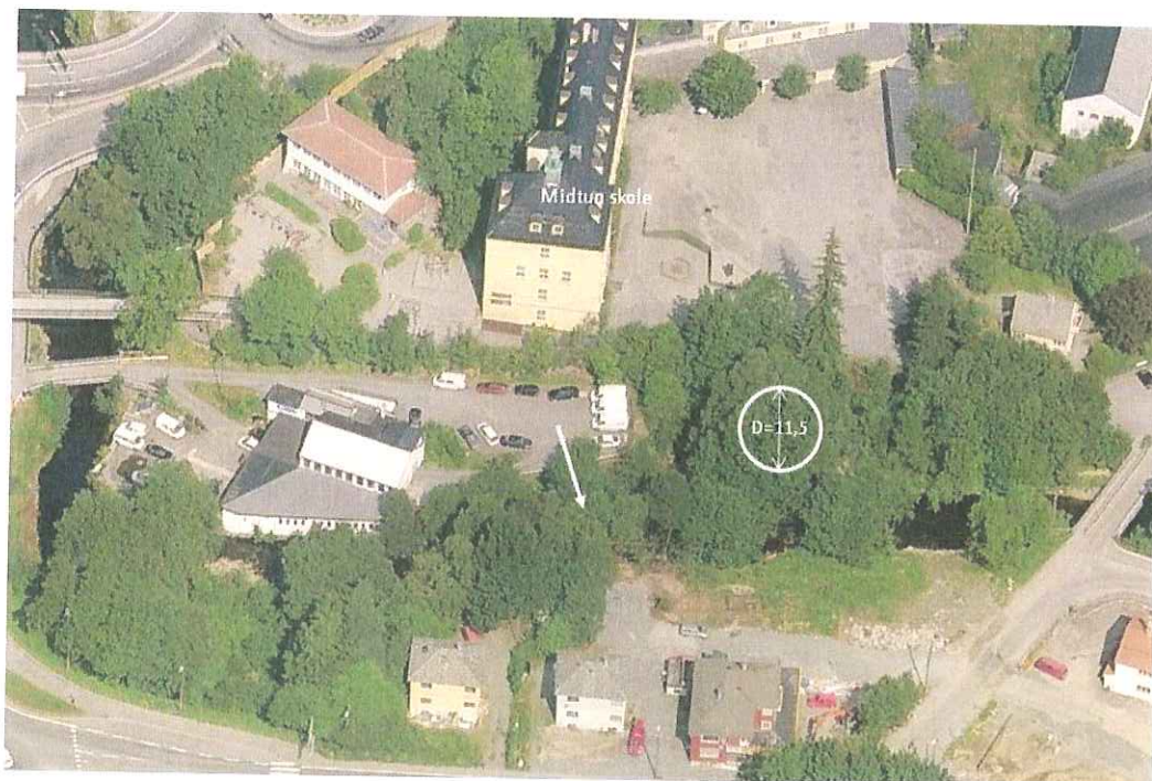
Figur 6 Flyfoto over østlige påhugg sett mot nord. Sirkel viser plasseringen av inntaket og hvit pil angir hvor bildet (figur 7) under i er tatt.
