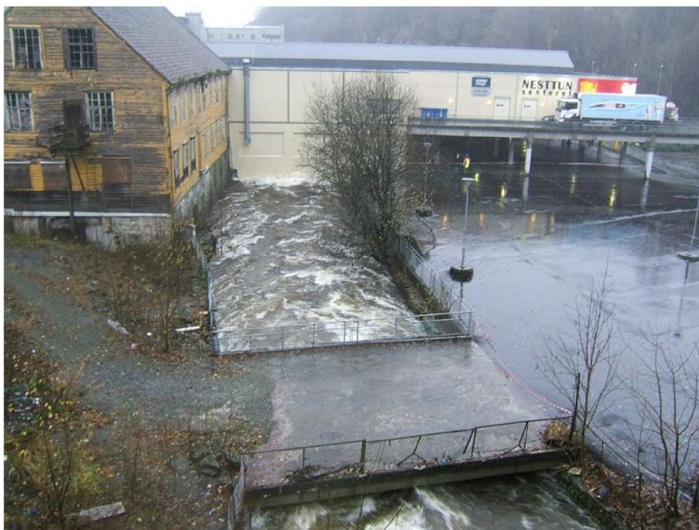
Foto: Nesttunelven i ferd med å gå opp under gulvet på Nesttun senter ifm. flom i elven høsten 2005.
