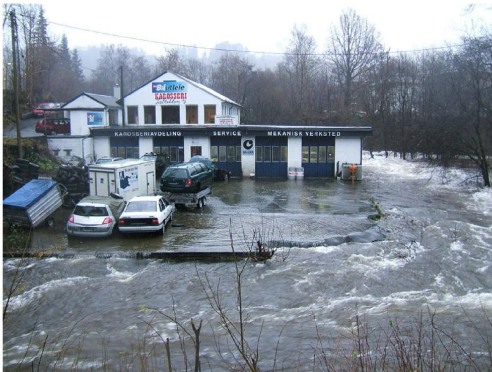
Foto: Store vannmasser i Nesttuneleven if. flom i eleven høsten 2005. Fotografi tatt like nedstrøms planlagt inntak til ny flomtunnel.
