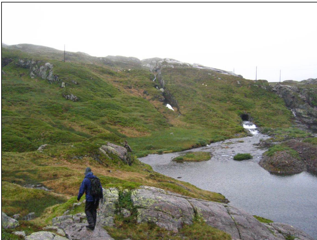
VEDLEGG 7. Eksisterende tappetunnel for Nedra Dukavatn.
