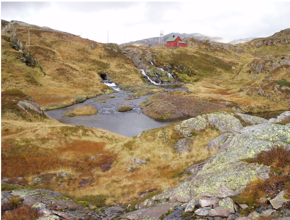
Bilde 3: Utløpet av eksisterende tappetunnel.
