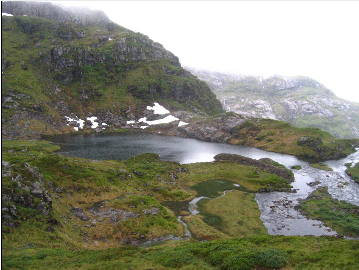
VEDLEGG 8. Vannet hvor tappetunnelen munner ut. Dukeelva til høyre i bildet.
