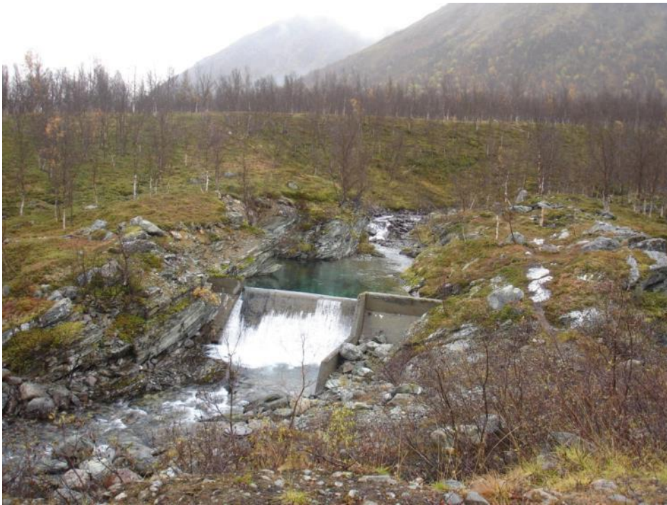
Figur 5-3. Eksisterende vannverksdam på kote 134.
