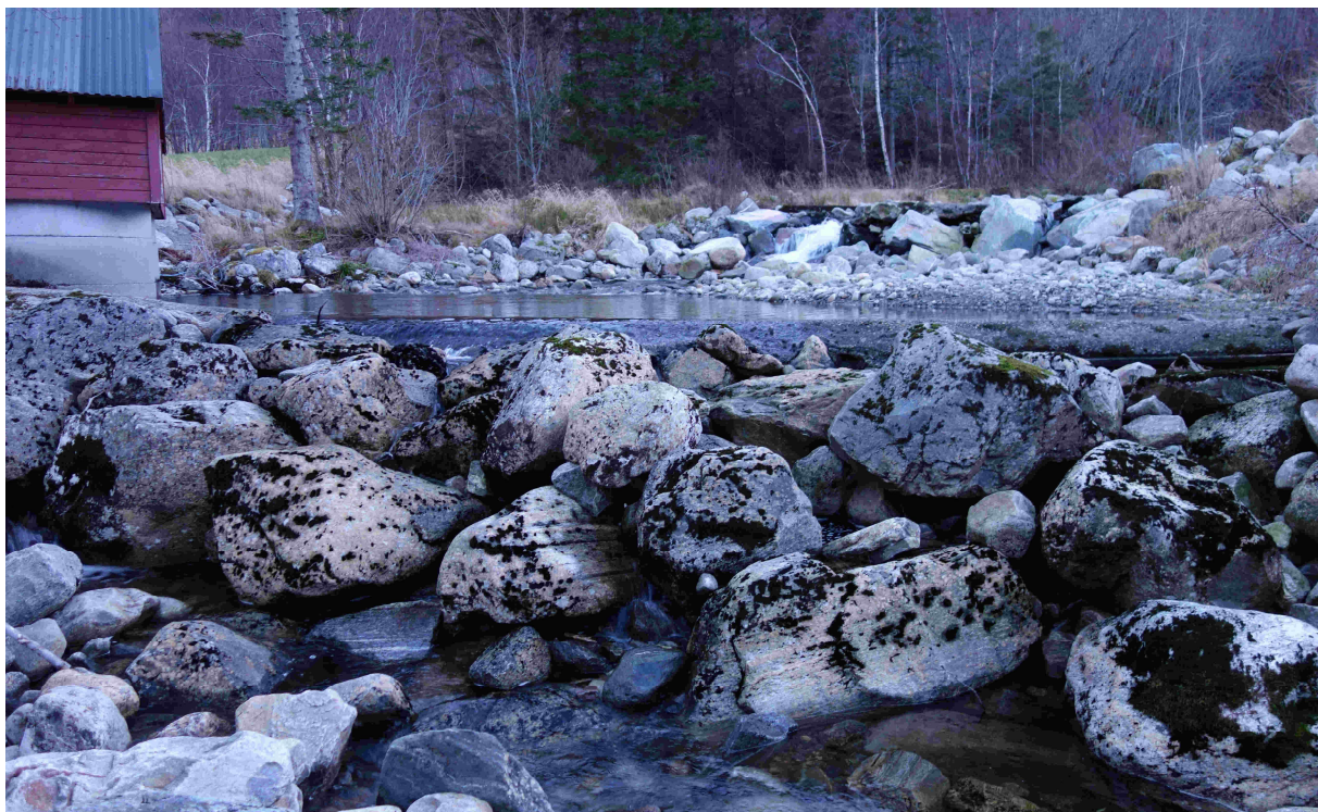
Figur 13. Biletet viser begge dei to inntaka med demningar, om lag 150 meter frå sjøen i Eikeelva. Som ein ser er ingen av desse særleg høge, og anadrom fisk vil truleg kunne passere desse på gunstig vassføring. Ål vil heller ikkje ha noko problem med å forsere desse. Nils Sverre Eik fortel elles at det aldri har gått opp anadrom fisk i denne elva, heller ikkje før inntaka for smoltanlegga vart etablert. (Foto; Solfrid Helene Lien Langmo © 12.12.2014).
