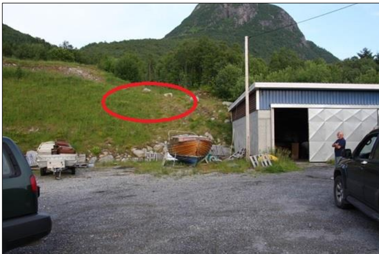
Bilde 2. Bilde fra kraftstasjonsområdet. Stasjonsbygg i oval sirkel
