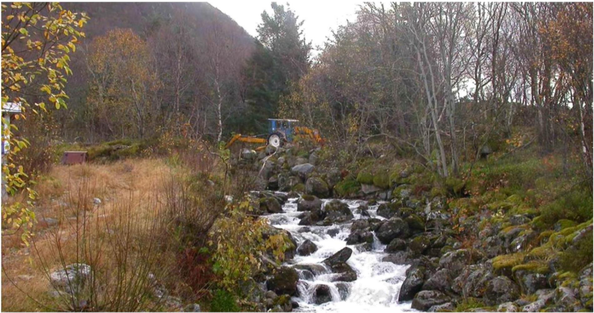
Bilde 1 Bildet tatt 24/10-08. Beregent vannføring 0,397 \text{ m}^3/\text{s}
