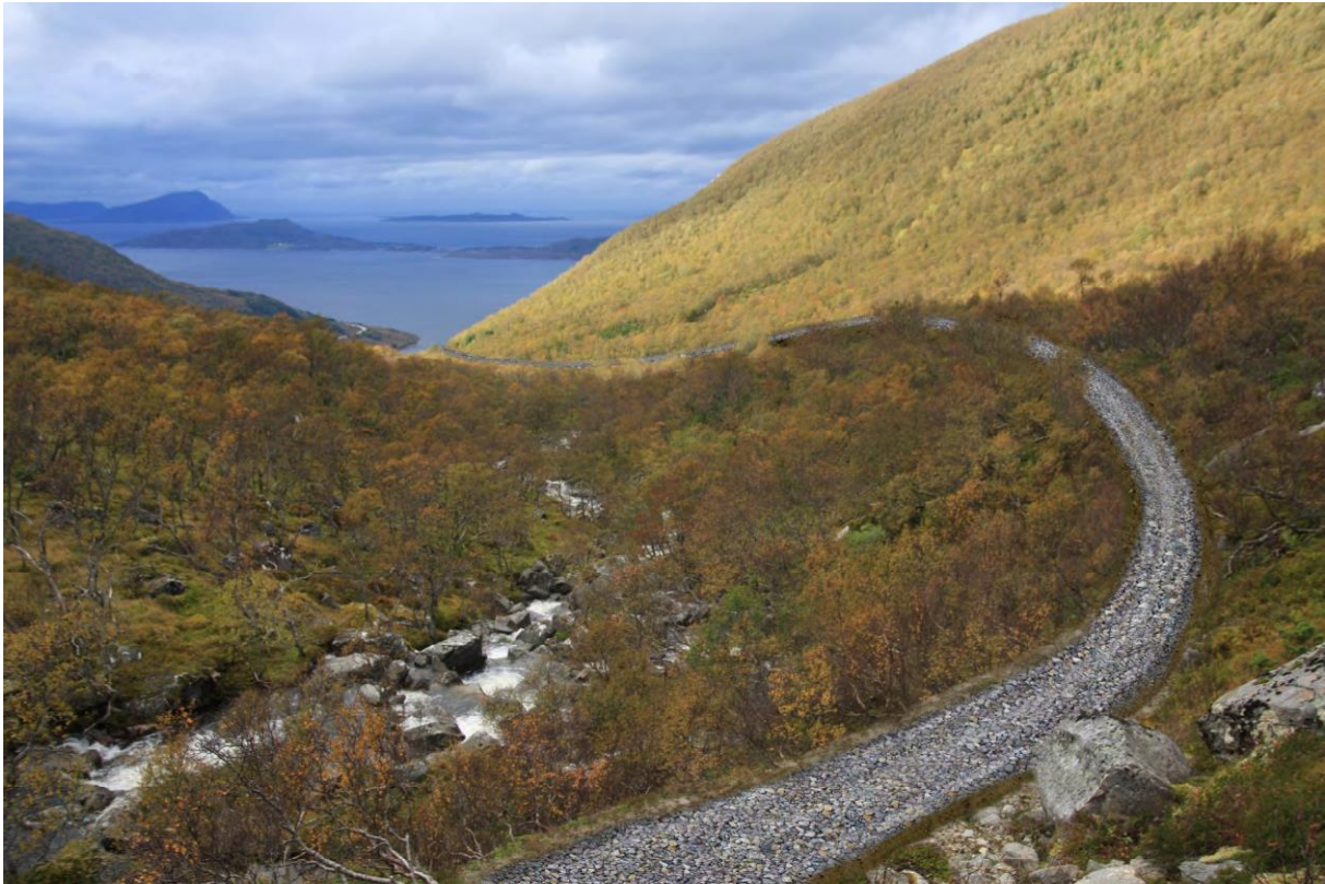
Bilde med innlagt rørgate like nedsrøms inntak.
