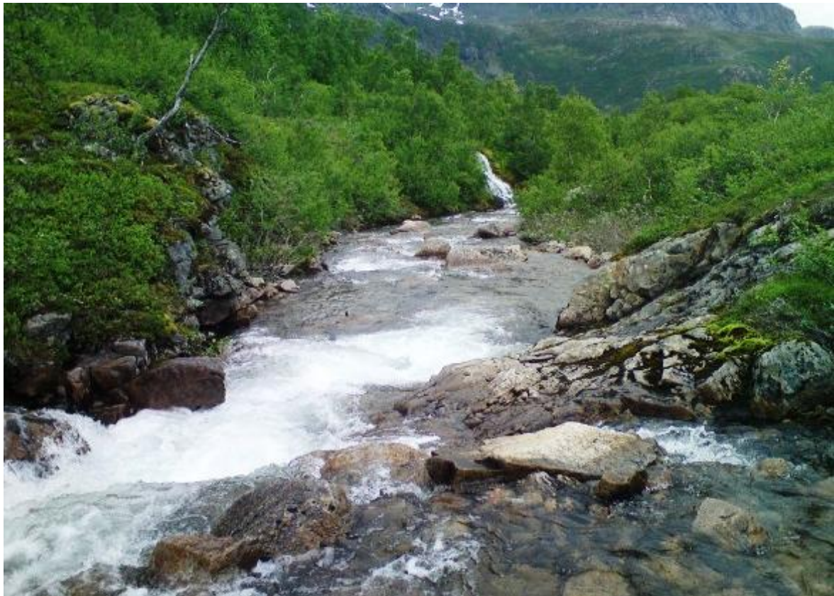
Bilde 17: Dalelva like oppstrøms hovedinntaket. Hovedinntaket etableres like nedstrøms bekken som vises oppe i midten av bildet. Det blir etablert vannspeil fra hovedinntaket og sørover. Bildet er tatt mot nord.
