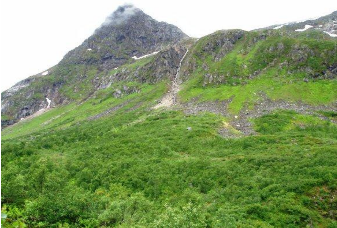
Bilde 20: Bekken midt i bildet renner naturlig ned i Dalelva oppstrøms hovedinntaket. Nord for denne bekken (til venstre i bildet) graves ned et overføringsrør ovenfor tregrensen og fram til to bekker lengre nord.
