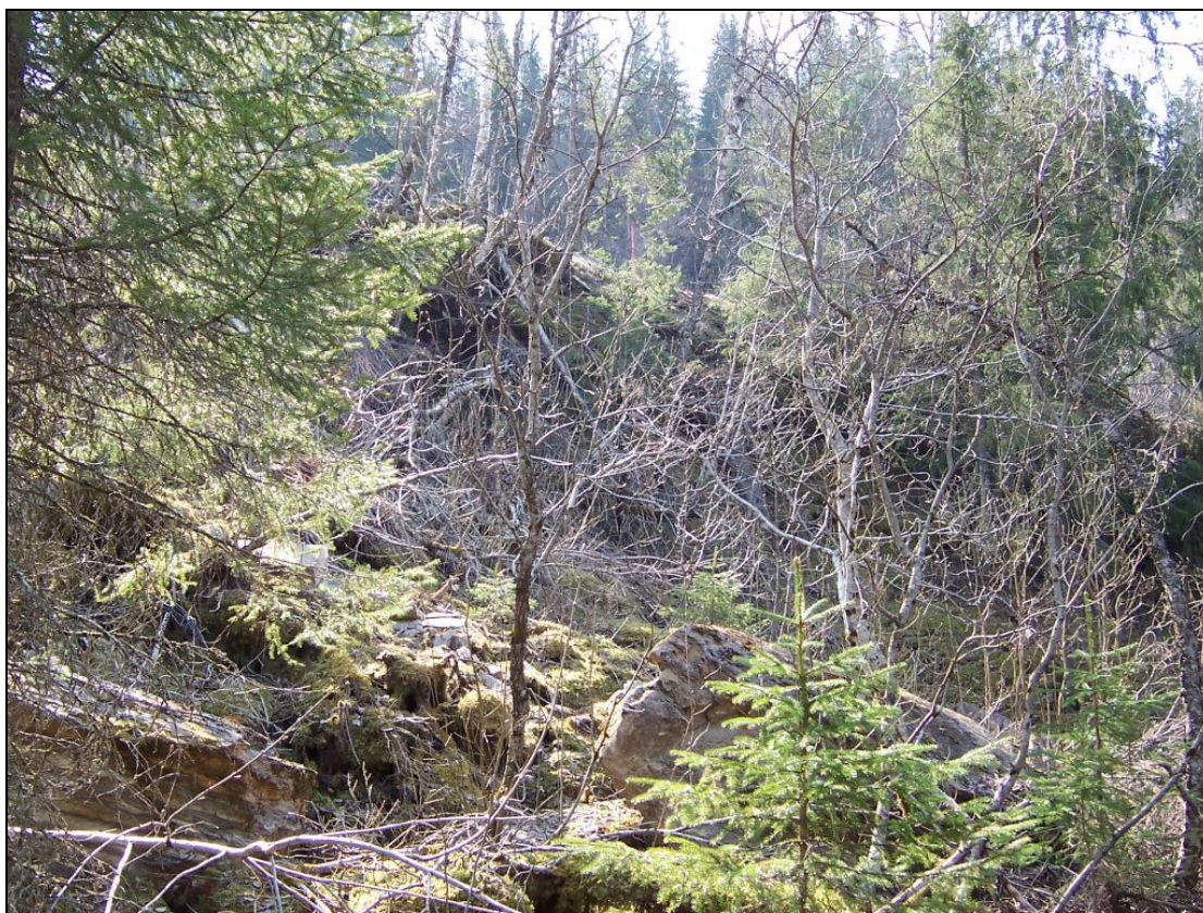
Bilde nr 10: Parti av røtraseen i øvre del av Hølbekken.
