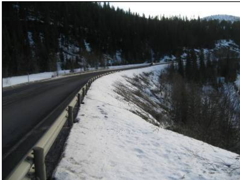
Figur 16: Statens vegvesen planlegger å gjøre svingen på dagens E6 trase i Hulbekkbukta slakkere ved at veien legges nærmere jernbanen som ligger til høyre for bildet.
