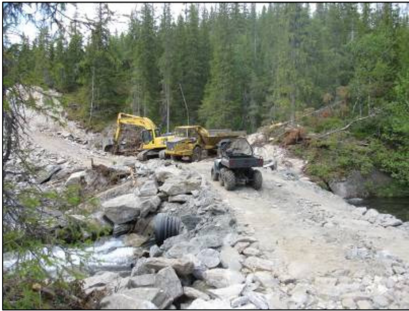
Figur 9: Dersom løsningen blir profilboret tunnel gjennom Høgåsen vil utslagspunktet bli i området bak dumper og gravemaskin som vi ser midt i bildet. Evt. rørgate vil gå der nevnte maskiner står parkert og følge veitraseen som vi ser til venstre i bildet.
