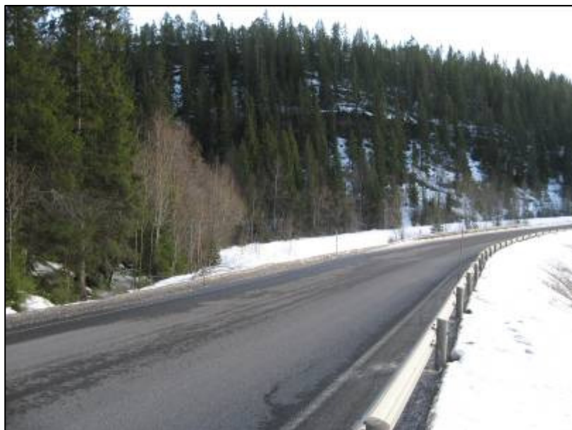
Figur 14: Kraftstasjonen blir liggende på oversiden av dagens E6 trasé til venstre for det hvite partiet midt i bildet. I veipakke Helgeland planlegger Statens vegvesen at svingen gjøres slakkere ved at arealet mellom E6 og jernbane blir fylt ut og tatt i bruk som nytt areal for veitraséen.
