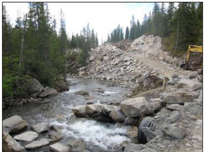
Figur 10: Evt. rørgrøft vil følge den utsprenge veitraseen som vi ser like til høyre for midten av bildet. Dersom hevert blir løsningen antar man at nødvendig grøftedybde blir 4 – 5 meter på det dypeste. Resterende høyde for å få vannet til å renne riktig vei vinnes via hevertprinsippet.
