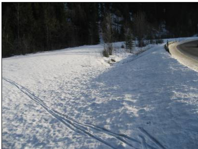
Figur 15: Den gamle veitraséen synes fortsatt godt i området der den ligger til siden for dagens E6 trasé. Denne planlegges brukt som adkomstvei til kraftstasjonen. Kraftstasjonsbygget blir liggende fra midten av bildet og til venstre.
