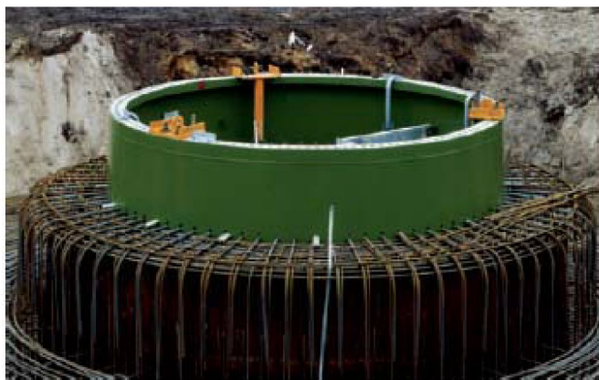
Figur 9: Eksempel på vindturbinfundament og montering av turbin ved hjelp av spesialkran
