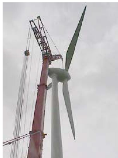
Figur 9: Eksempel på vindturbinfundament og montering av turbin ved hjelp av spesialkran
