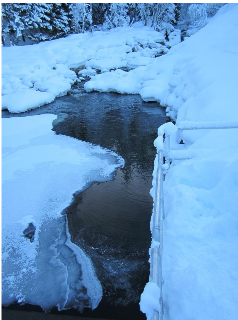
Figur 32: Åpen råk på inntaksdam (Foto: H. Opaker)
