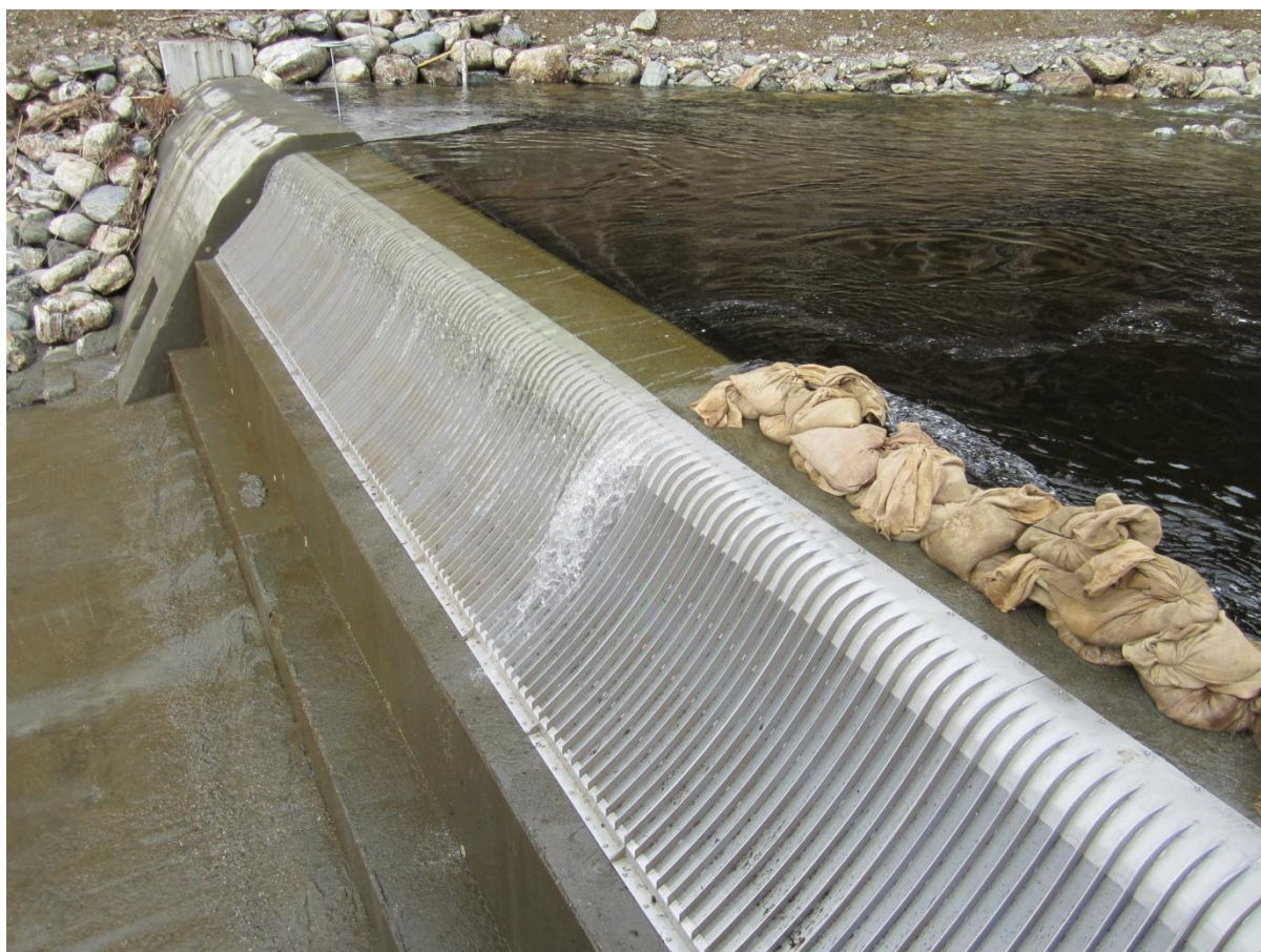
Figur 51: Innsnevring av overløp med sandsekker (Foto: H. Opaker)
