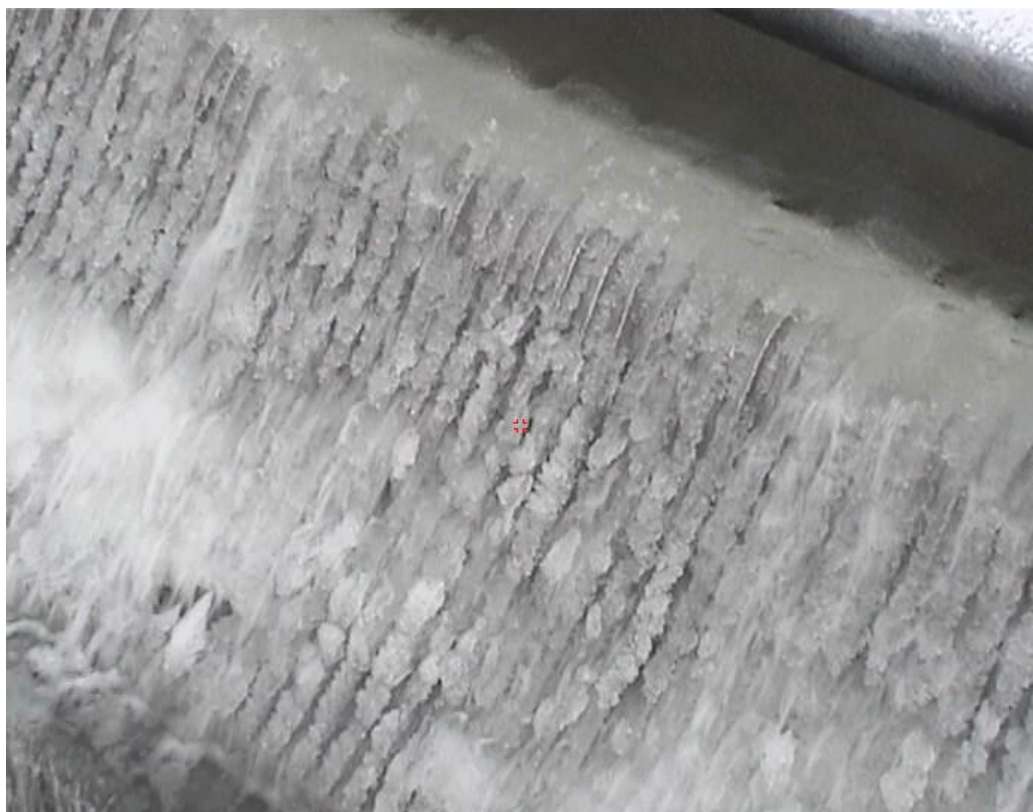
Figur 31: Gjenfryst coandarist (Foto: Tafjord Kraftproduksjon AS)
