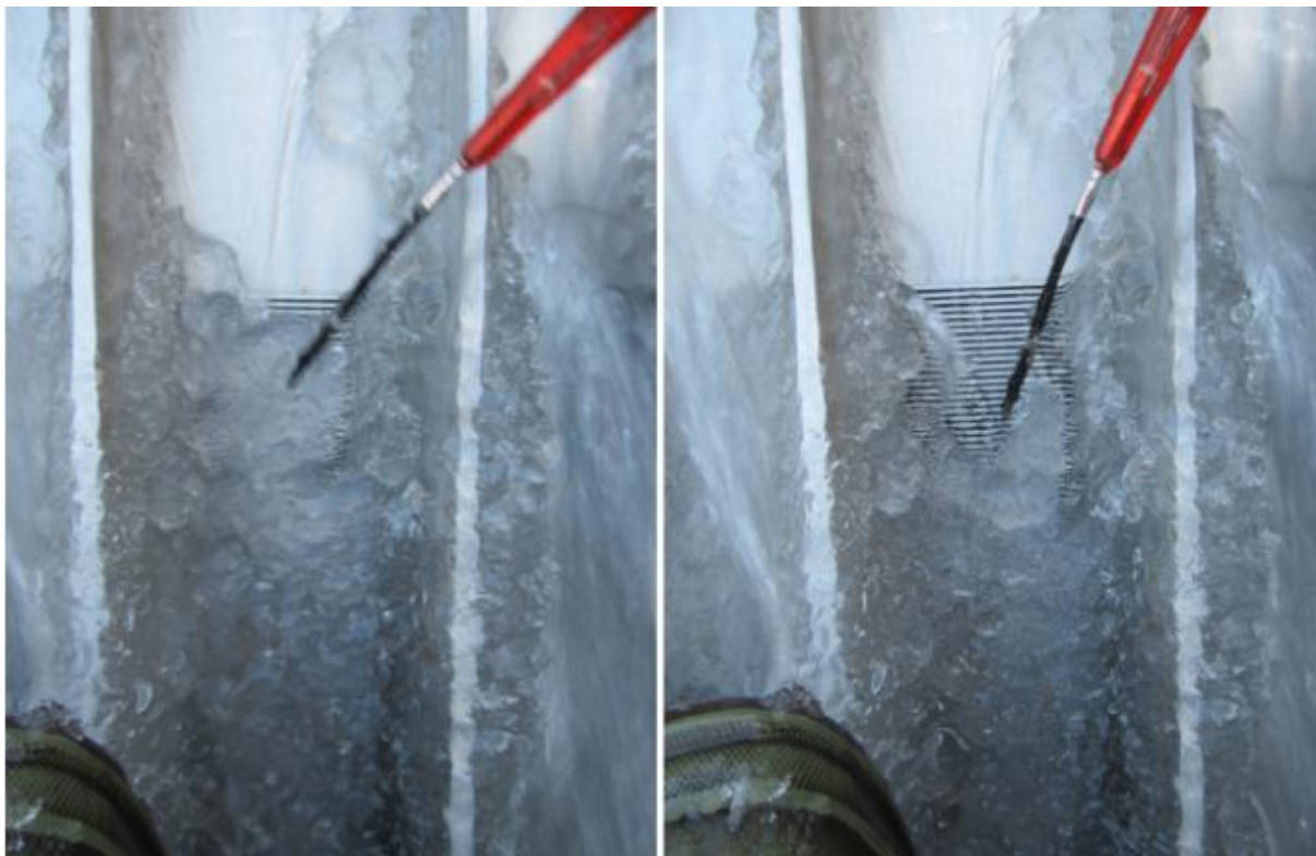
Figur 35: Avskrapning av sarr (Foto: H. Opaker)
