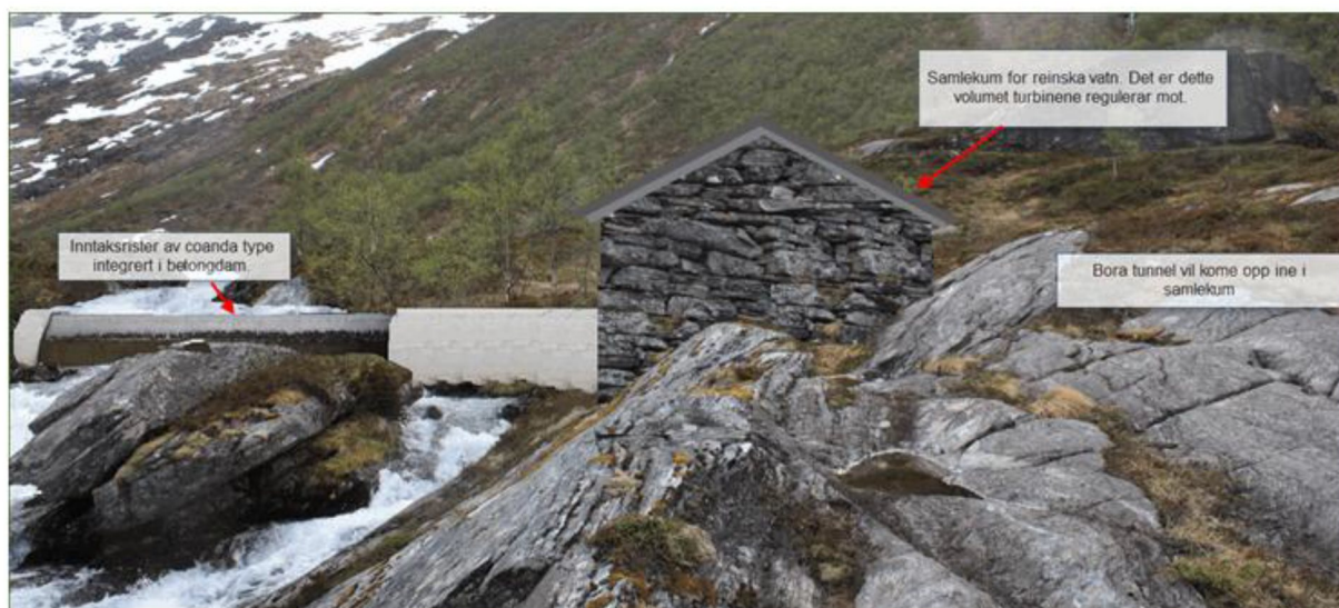
Figur 2.2.4.1 Fotovisualisering av coandainntak med samlekum i "seterstil".
