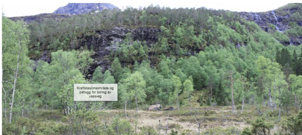
Figur 3.4.3 Kraftstasjonsområde og påhugg for tunnelboring nedanfor Skinnstøhammaren.
