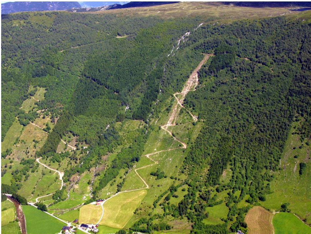
Fig. 3.3. Kjærlandslia. Elva har avgrensa verknad som landskapselement. Skogsvegane og kulturlandskapet er dominerande element. Den gamle kraftstasjonen litt nedanfor midten til venstre, ved kurve i skogsvegen.
