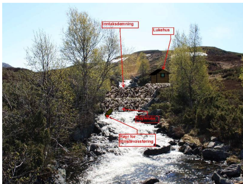
Fig. 2.5. Inntaksstad, om lag kote 540
