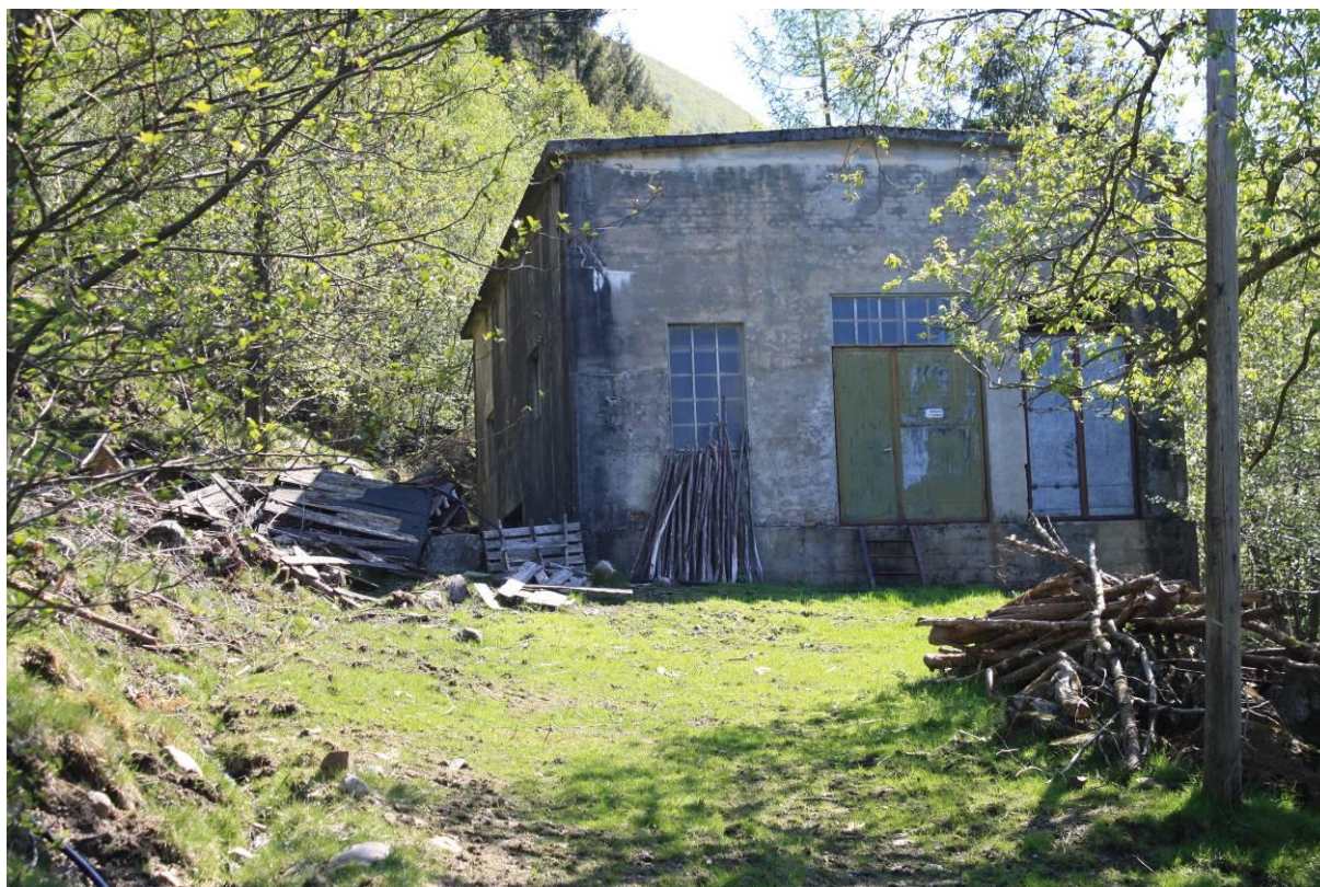
Bilete 10: Kraftstasjon kote ca. 115 moh.
