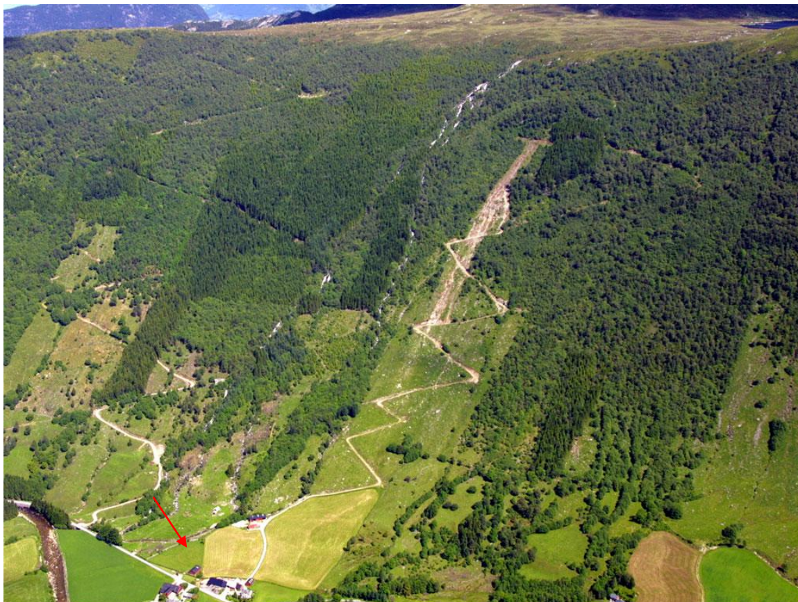
Figur 4.5. Flyfoto av lisida med Tverrelva, sett fra Uskedalen. Tverrelva renner mellom de to skogsveiene. Plassering av kraftstasjonen er markert med rød pil
