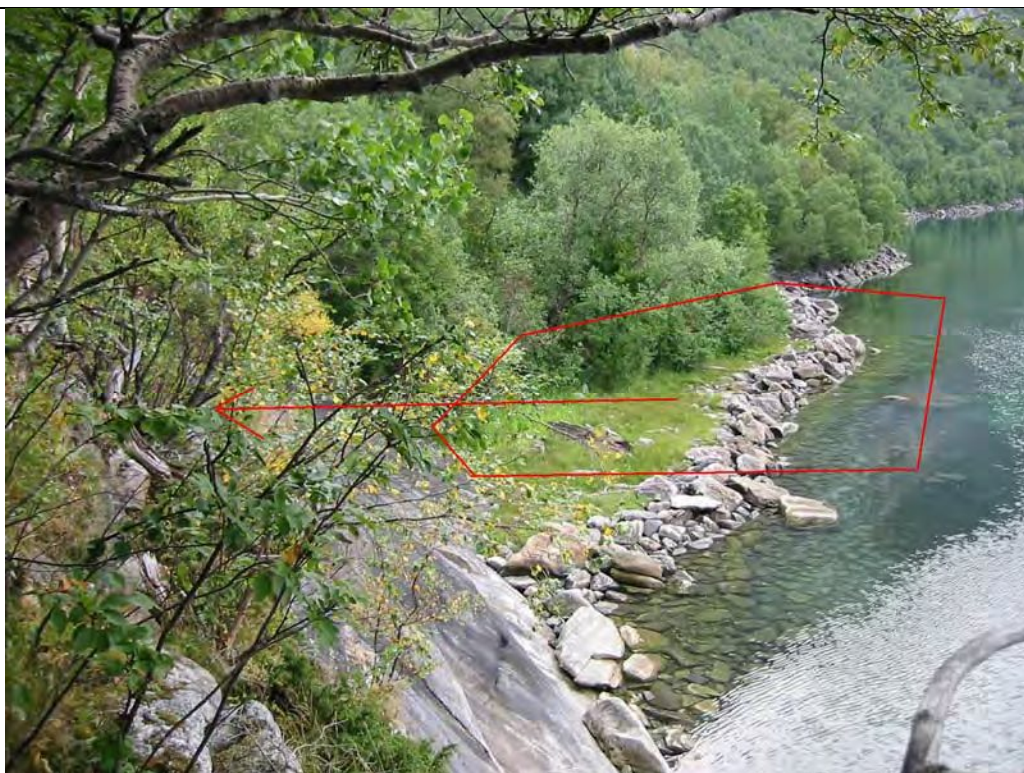
Bilde 2: Tunnelinnslag og riggområde, kaianlegg
