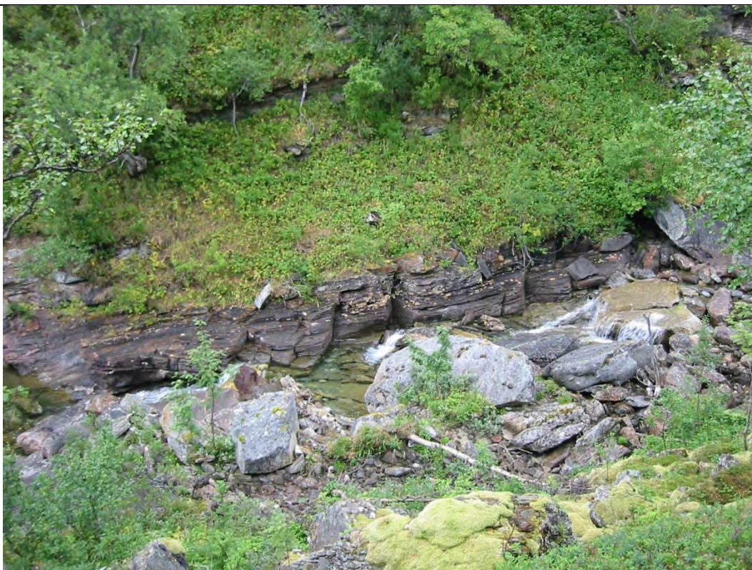
Bilde 5: Tydelig utvasking på berg mot nordsiden av Galtådalen
