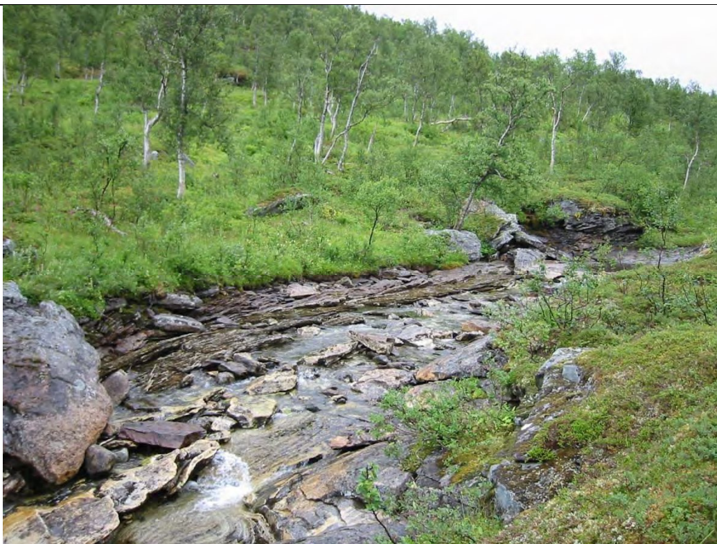
Bilde 9: Inntak med oversikt av oppstrøms side av dam
