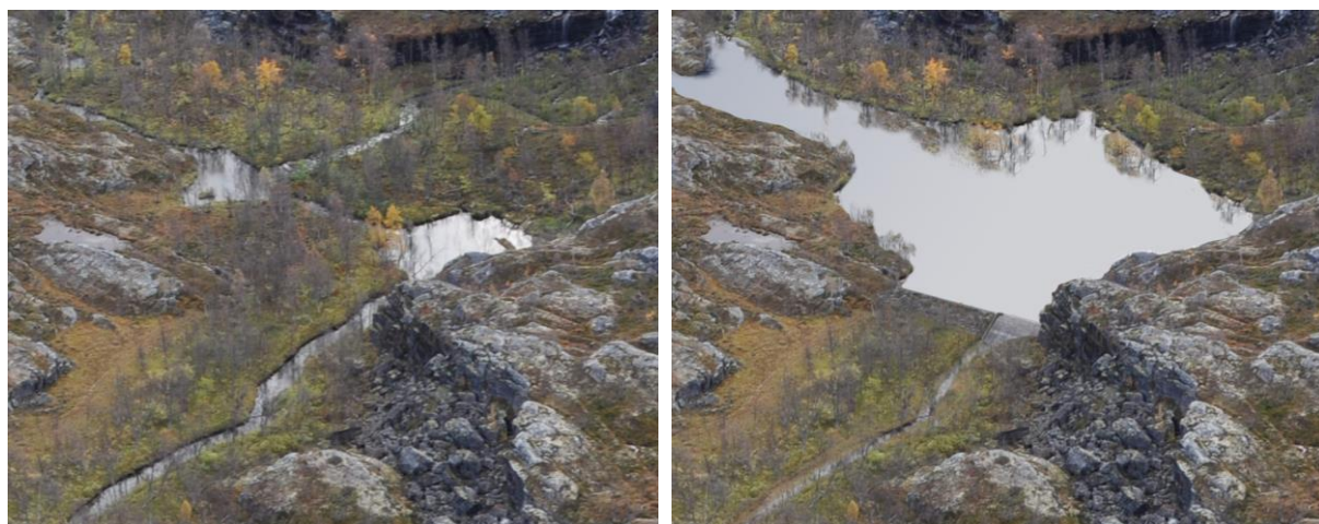
Figur 29 Situasjonen før (t.v.) og etter (t.h.) en utbygging er illustrert. Inntaksdammen ligger med god forankring inn mot en mindre kulle til høyre i bildet og i skjul fra en større bergvegg i sør. Inntaksbassenget med naturlig avgrensing ved kote 360 vil av de fleste oppleves som et positivt element i landskapsbildet.
