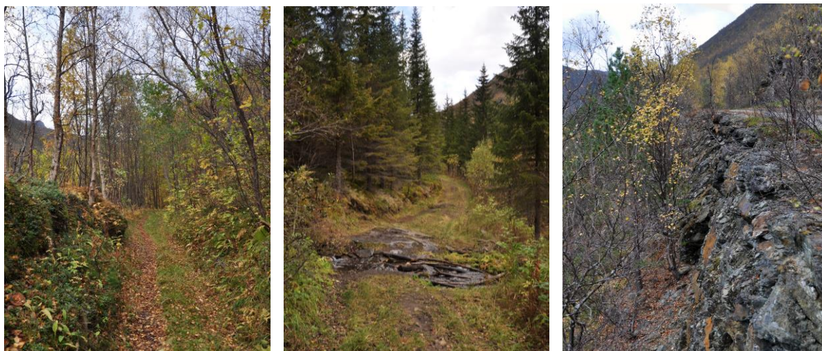
Figur 12 Vegen er nøye tilpasset terrenget, stedvis på oppbygde steinmurer som til høyre.
