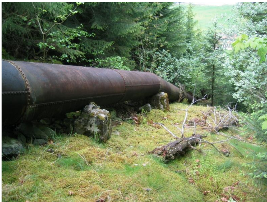
Figur 3-9 Rester etter den gamle rørgaten tilhørende Geiranger kraftverk.
