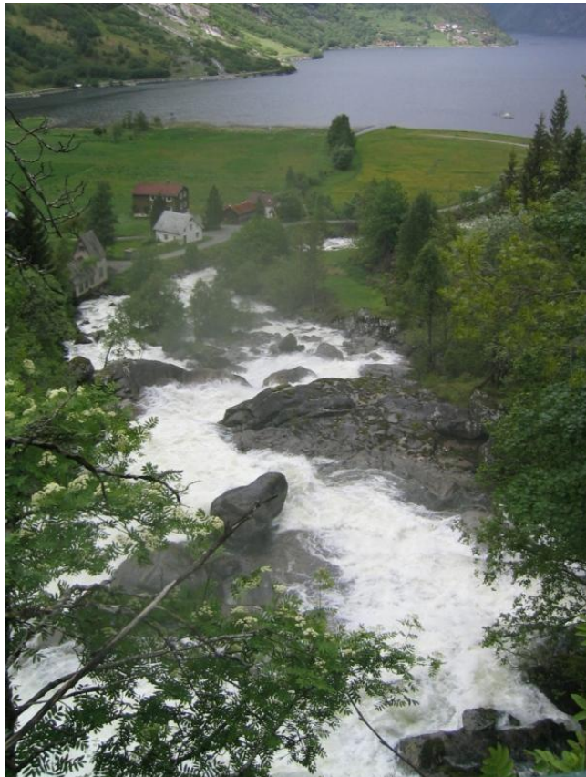
Figur 3-2 Geirangerelva sett fra utkikkspunktet på ca. kote 60. Den gamle kraftstasjonsbygningen er synlig på venstre elvebredd.
