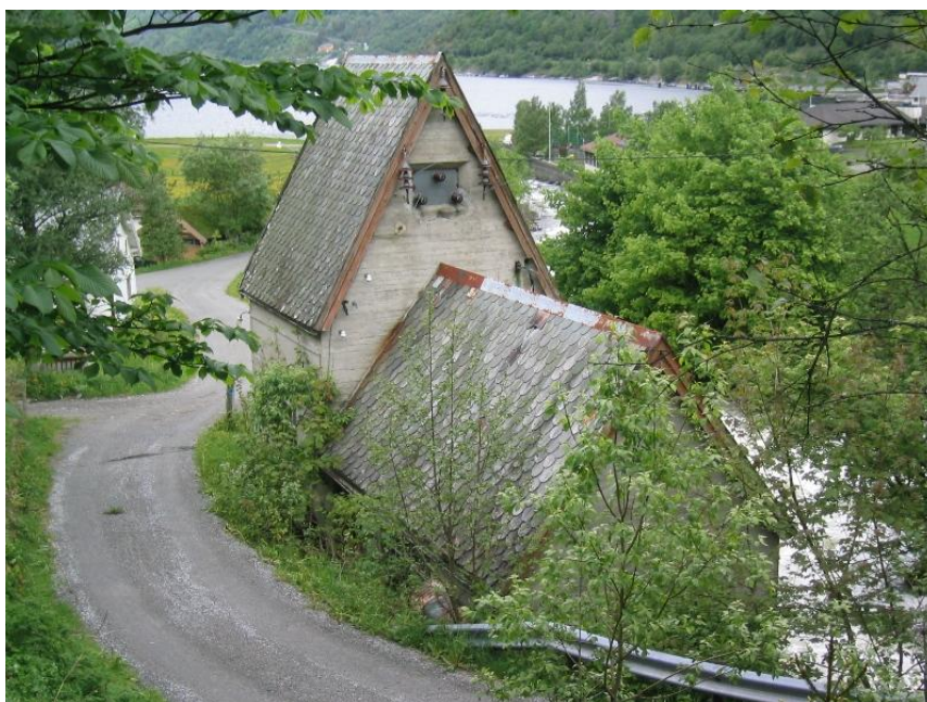
Figur 3-10 Den verneverdige kraftstasjonsbygningen fra 1928..
