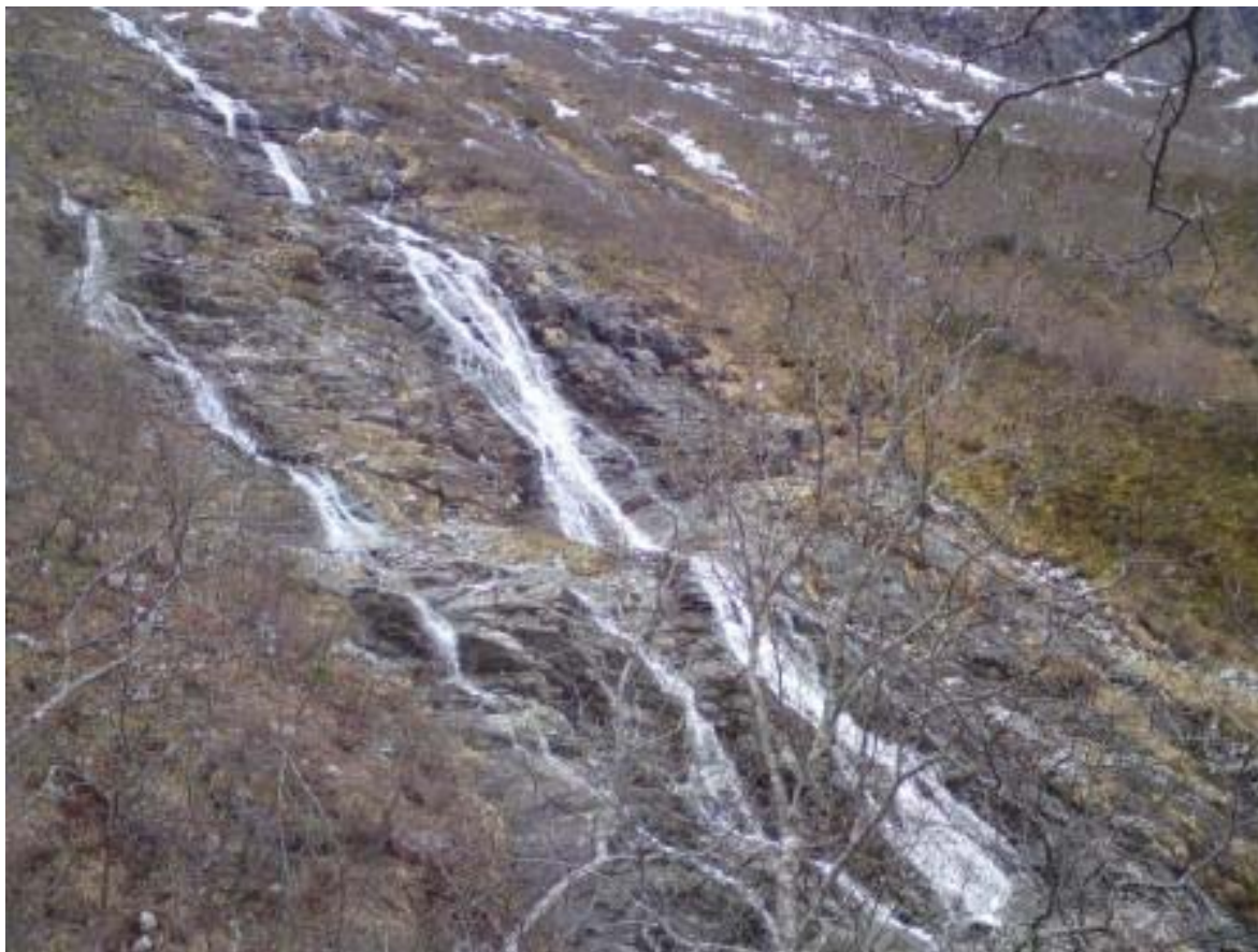
Bilde 5: Smøråa ca kote 380-410 moh. I partiet mellom bekken til venstre og bekken til høyre overføres vann i åpen kanal. I partiet til høyre for bekken til høyre i bildet overføres vann delvis i åpen kanal og delvis i nedgravd rør.
