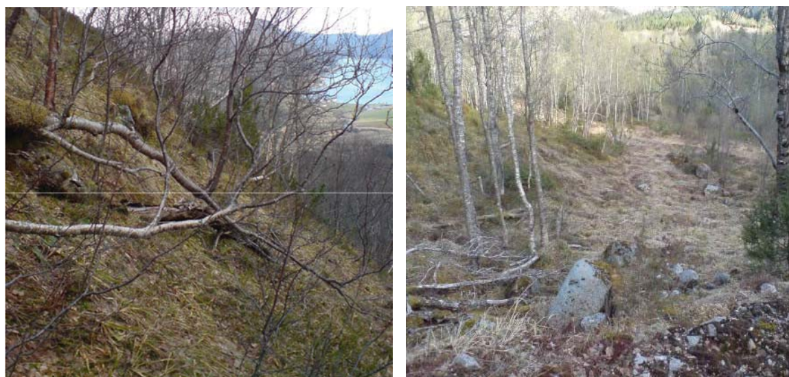
Figur 2-9 Bilder fra vestsiden av Smøråa. Bilde til venstre viser øvre del av rørtrasé og bilde til høyre er tatt lengre nedstrøms..
