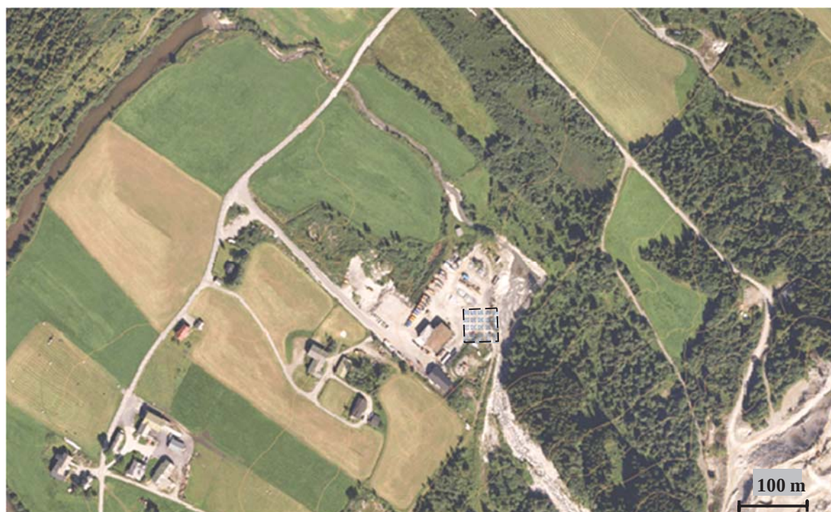
Figur 2-2 Smøråa kraftverk, nedre del av tiltaksområdet. Stasjonsområdet er planlagt på vestsiden av Smøråa og på østlig del av industriområdet som er vist midt i bilde. Stasjonsområdet er vist med stiplede firkant.
