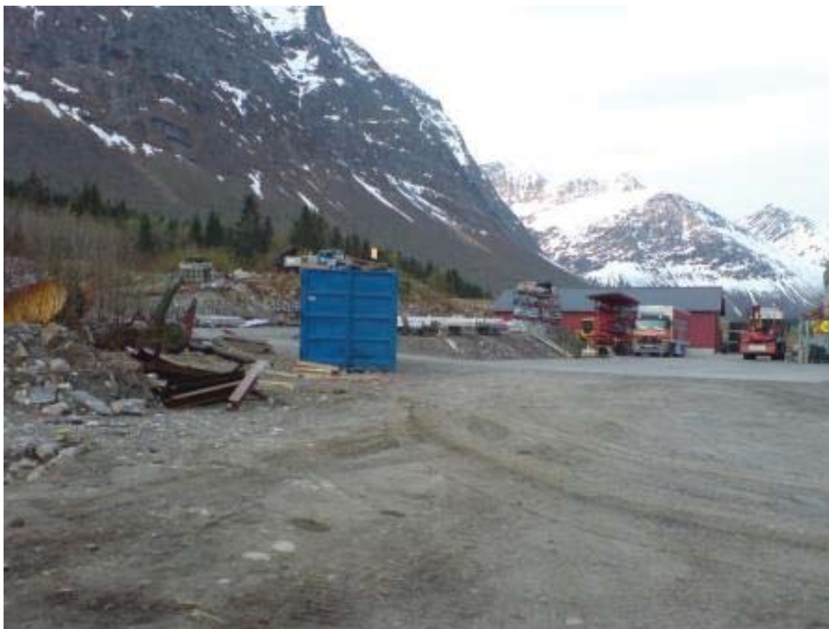
Bilde 14: Stasjonsområdet sett mot sørvest. Kraftstasjonen plasseres innenfor dette området.
