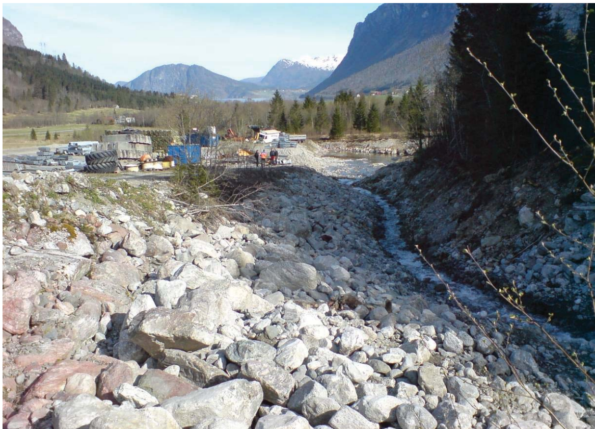
Bilde 13: Nedre del av rørtraseen sett i retning nord. Kraftstasjonen plasseres i øvre venstre del bildet.
