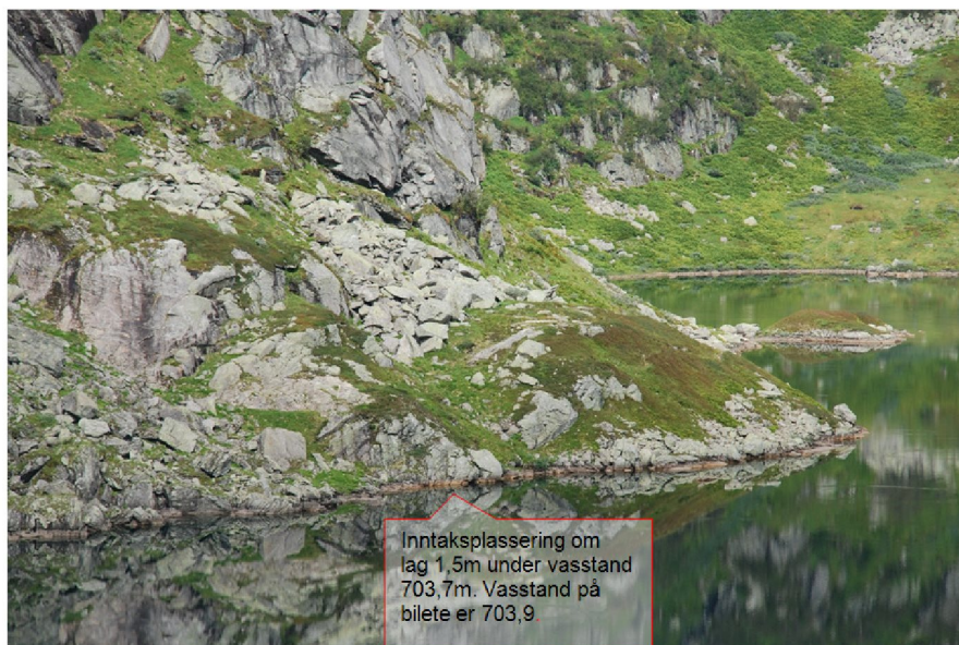
Figur 4-4. Inntaksplassering sett nordover
