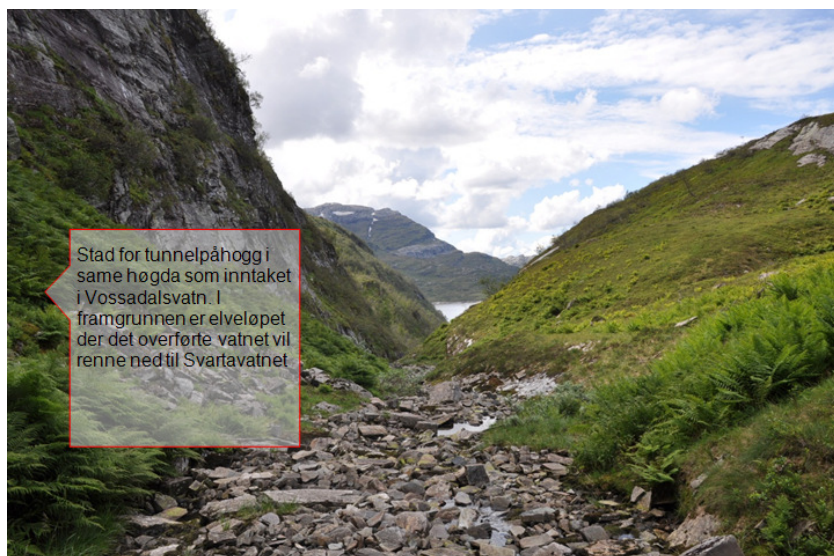
Figur 4-6 Foto av tunnelpåhogg
