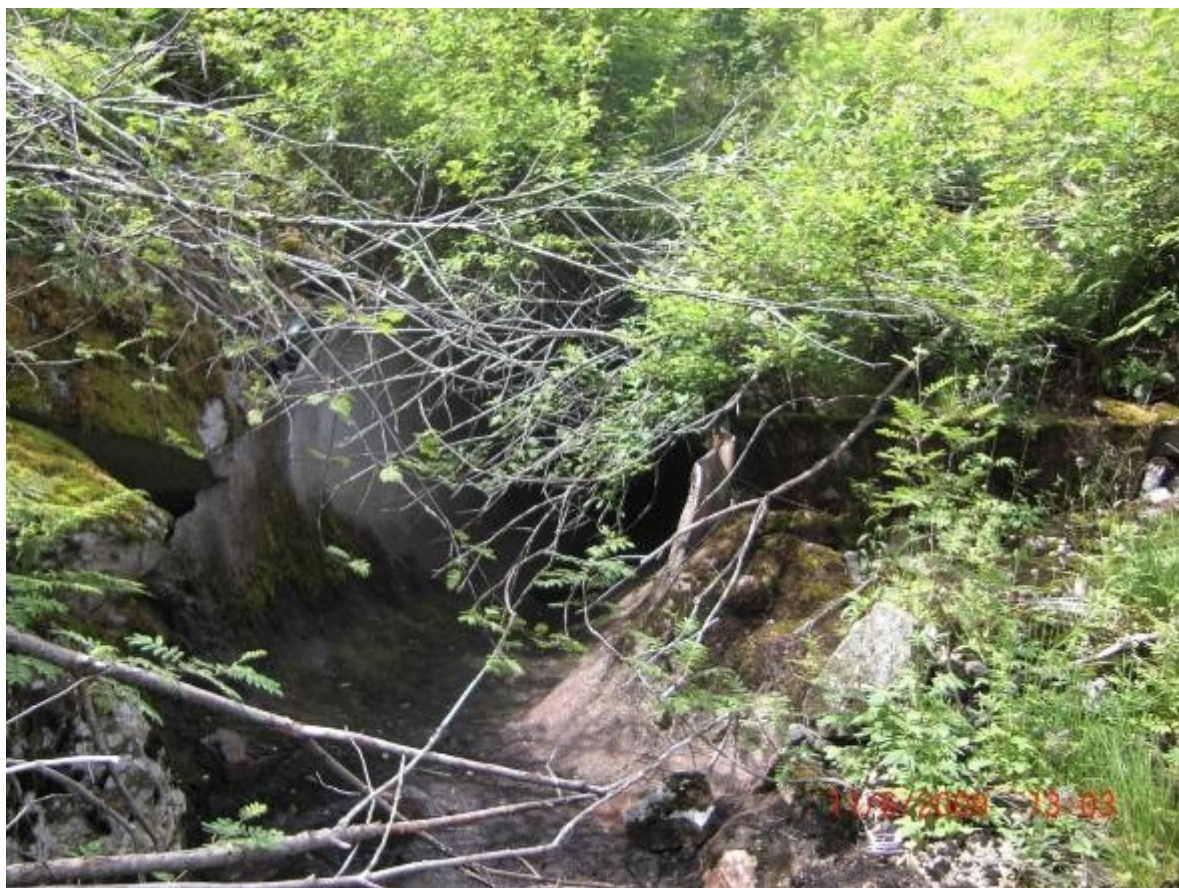
FIGUR 34: BILDET VISER HVOR BEKKEN KRYSSER TIDLIGERE 391 RØR.
