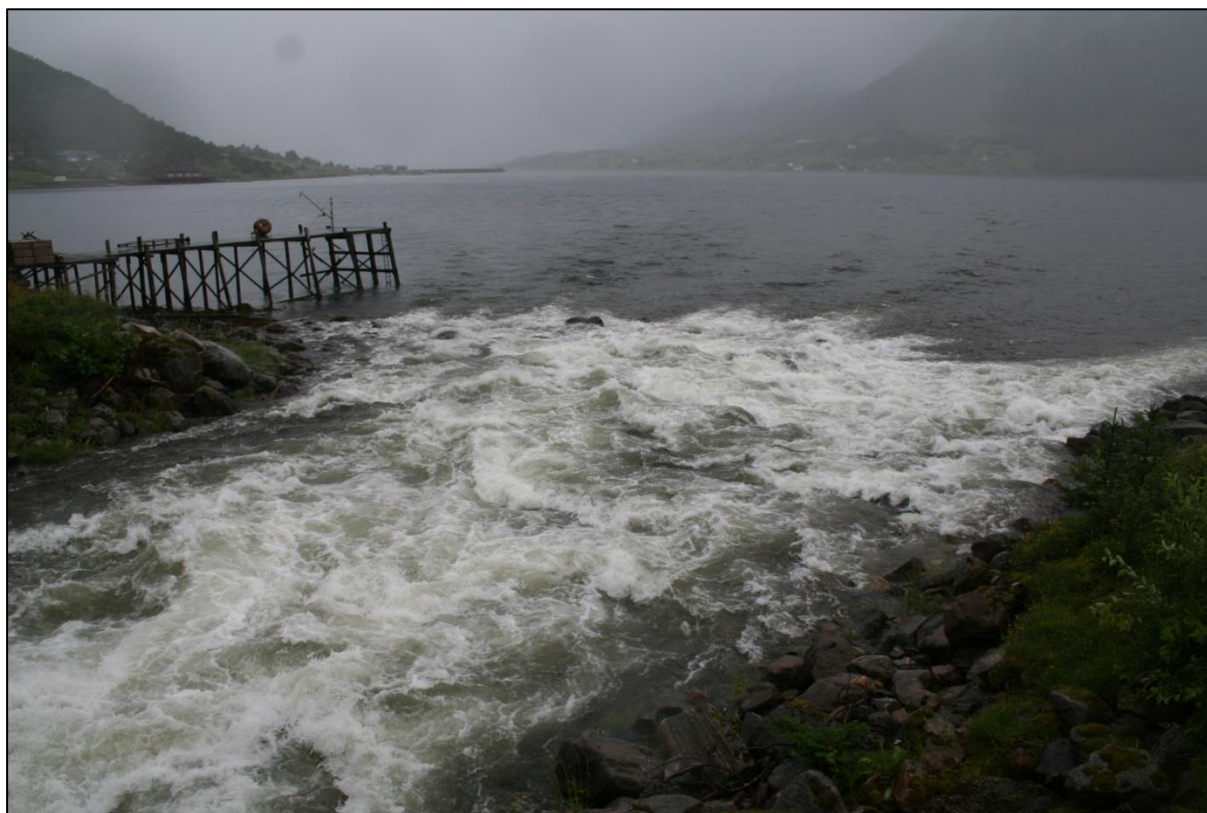
UTLØPET TIL KJERRINGÅGA SETT FRA RIKSVEIEN. 9. JULI 2013. VANNFØRINGEN PÅ BILDET ER 19,77 m 3 /s, DVS 810 % AV MIDDELVANNFØRING.
