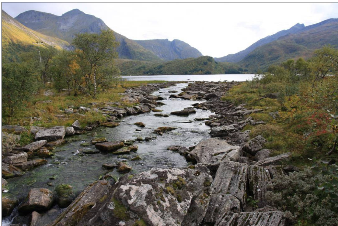
Figur 3. Bildet viser planlagt plassering av inntaket ved utløpet av Vassvatnet. Bildet er tatt fra broen som krysser Kjerringåga. Rørledningen vil bli gravd ned og ligge på høyre side av elva. Foto: Ingve Birkeland.
