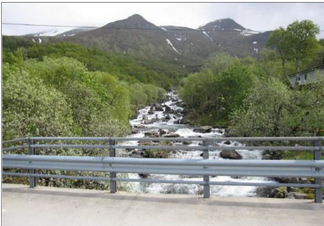
KJERRINGÅGA SETT FRA RIKSVEIEN.
