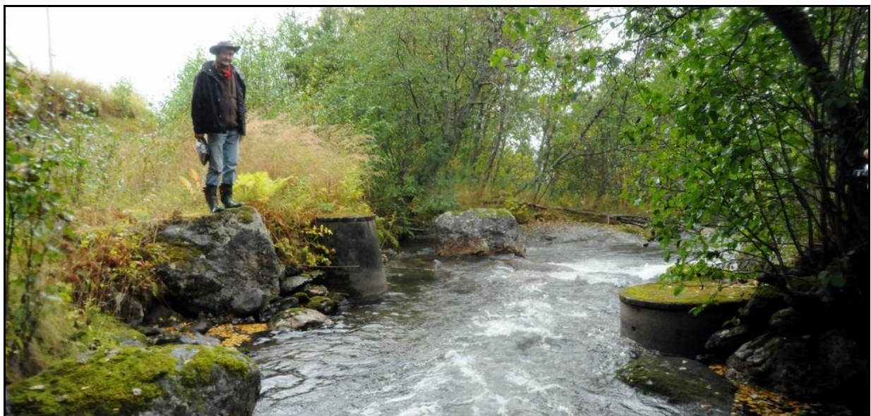
Figur 18. I alt fire drikkevannsinntak (kummer) i Løvdalselva forsyner til sammen 12 husstater og en driftsbygning langs Løvdalsstranda. Kartet over viser lokalisering av inntakene. Her er også registrerte vandringshindre for anadrom fisk avmerket.
