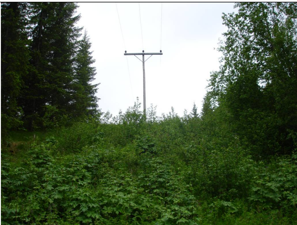
Bilde 8 Rørtraceen krysser under 22 kV-linja rett ovenfor kraftstasjonen
