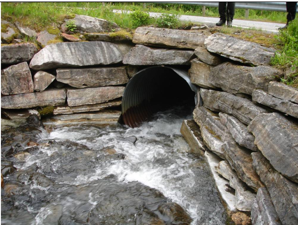
Bilde 10 Kulverten gjennom veien rett nedenfor kraftstasjonen
