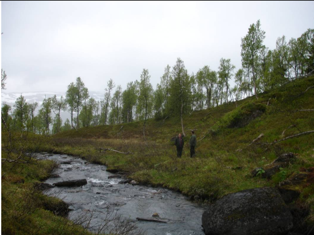
Bilde 5 Nedstrøms damstedet. Rørgata følger draget i yttersvingen av bekken.
