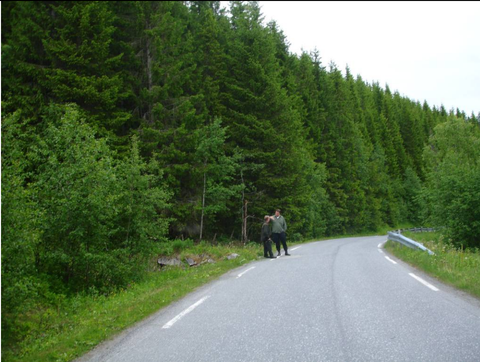
Bilde 9 Melandsbekken krysser veien rett før innløpet i Leiråga. Kraftstasjonen like til venstre i bildet
