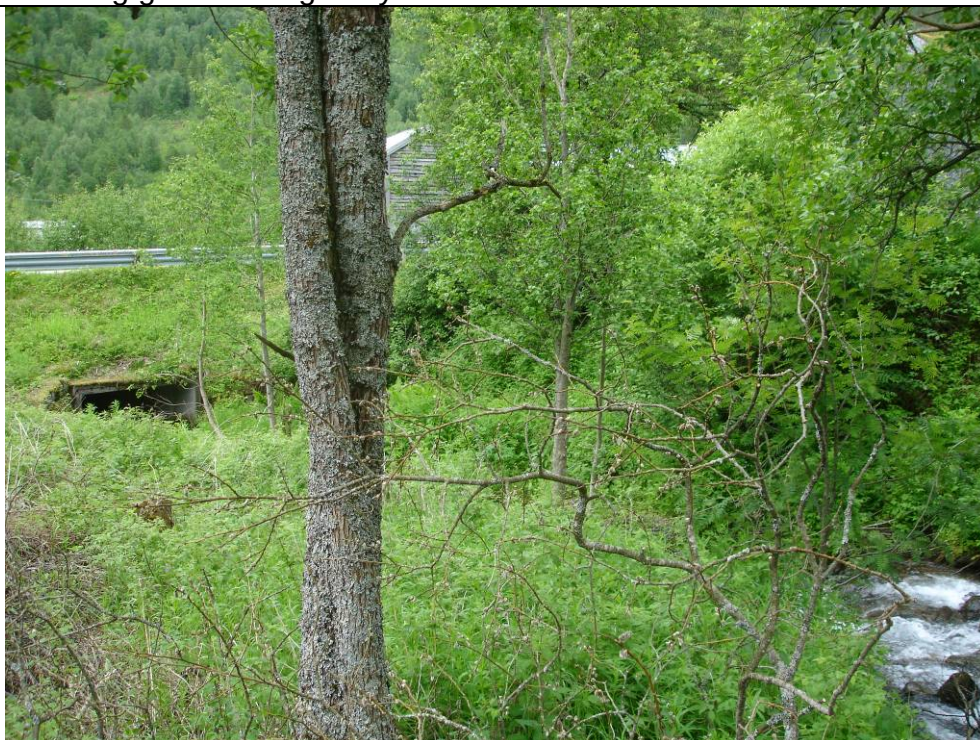
Bilde 12 Jamtjordbekken krysser fylkesveien, rett før den renner ut i Leiråga, ca. 250m nedstrøms kraftstasjonen. God kapasitet på veikulvert i tilfelle rørbrudd.
