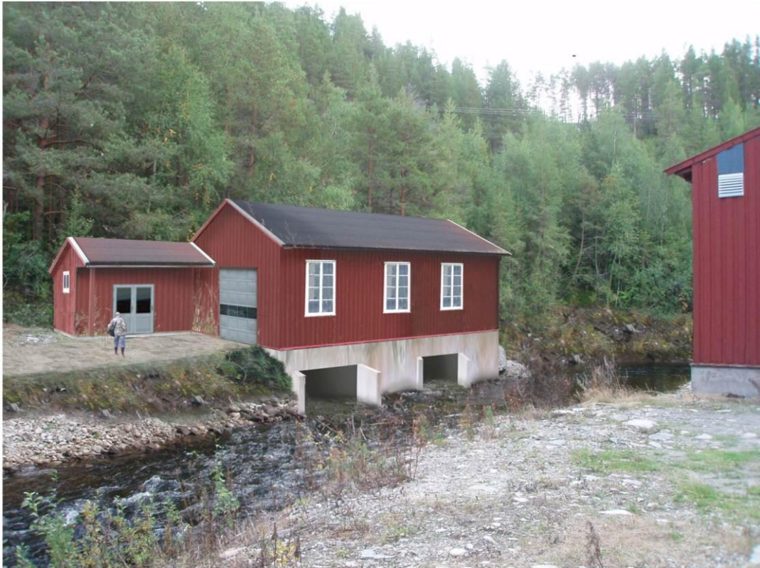
Figur 9. Fotovisualisering av nytt Sølva kraftverk (eksisterende kraftverk til høyre).
