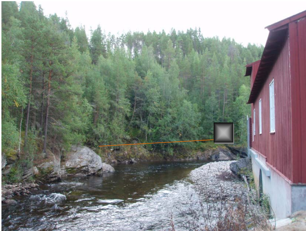
Bilde 4: Gammel kraftstasjon med påhugg og rørtrasé for nytt anlegg indikert.
