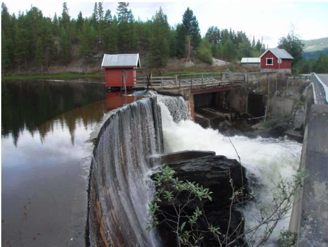
Bilde 7: Eksisterende inntaksdam
