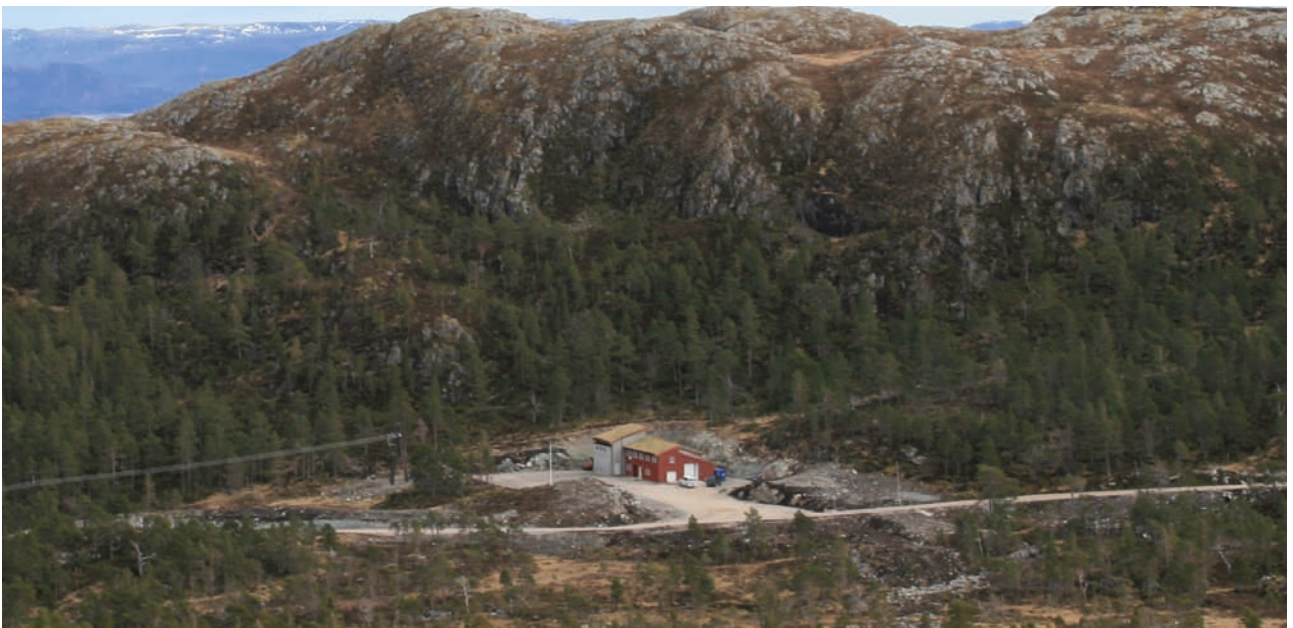
Figur 6-7 Transformatorstasjon og servicebygg. Eksempel fra Hitra vindpark (Foto: Trond Simensen, Sweco)
