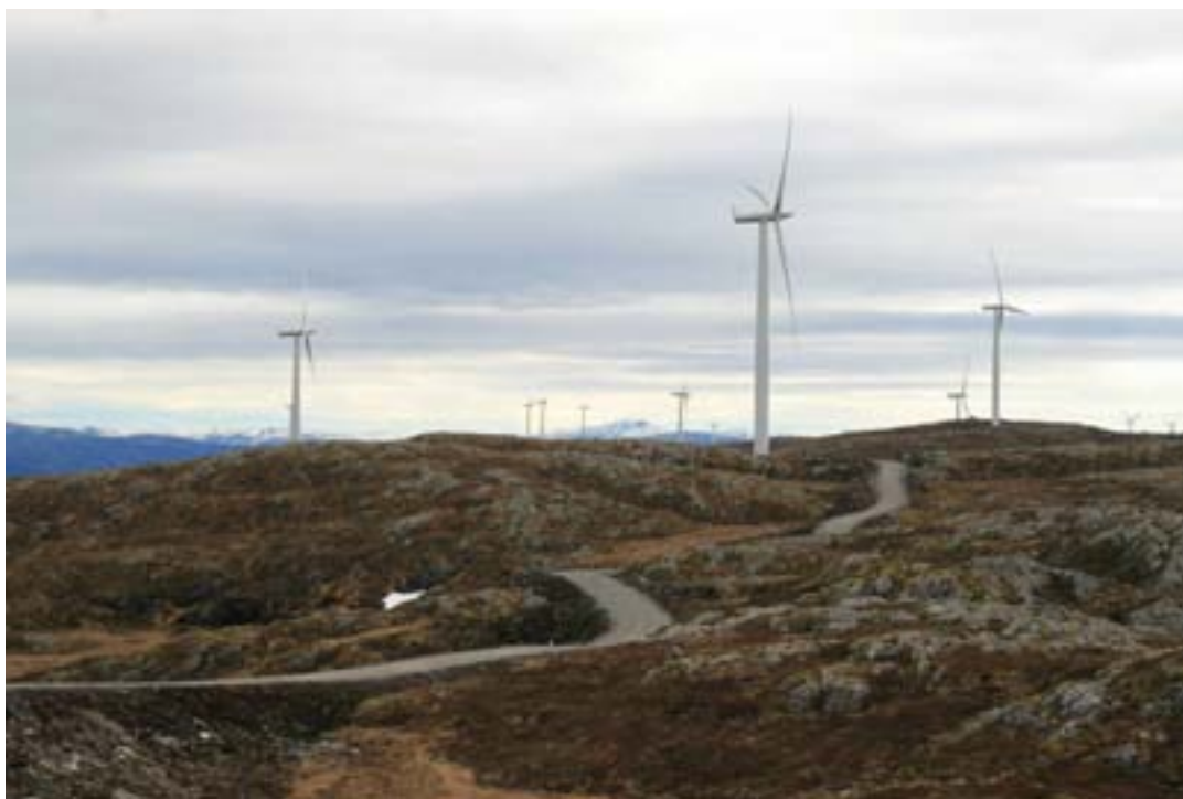
Figur 5.1: Interne veier i Hitra vindpark. Foto: Trond Simensen.
