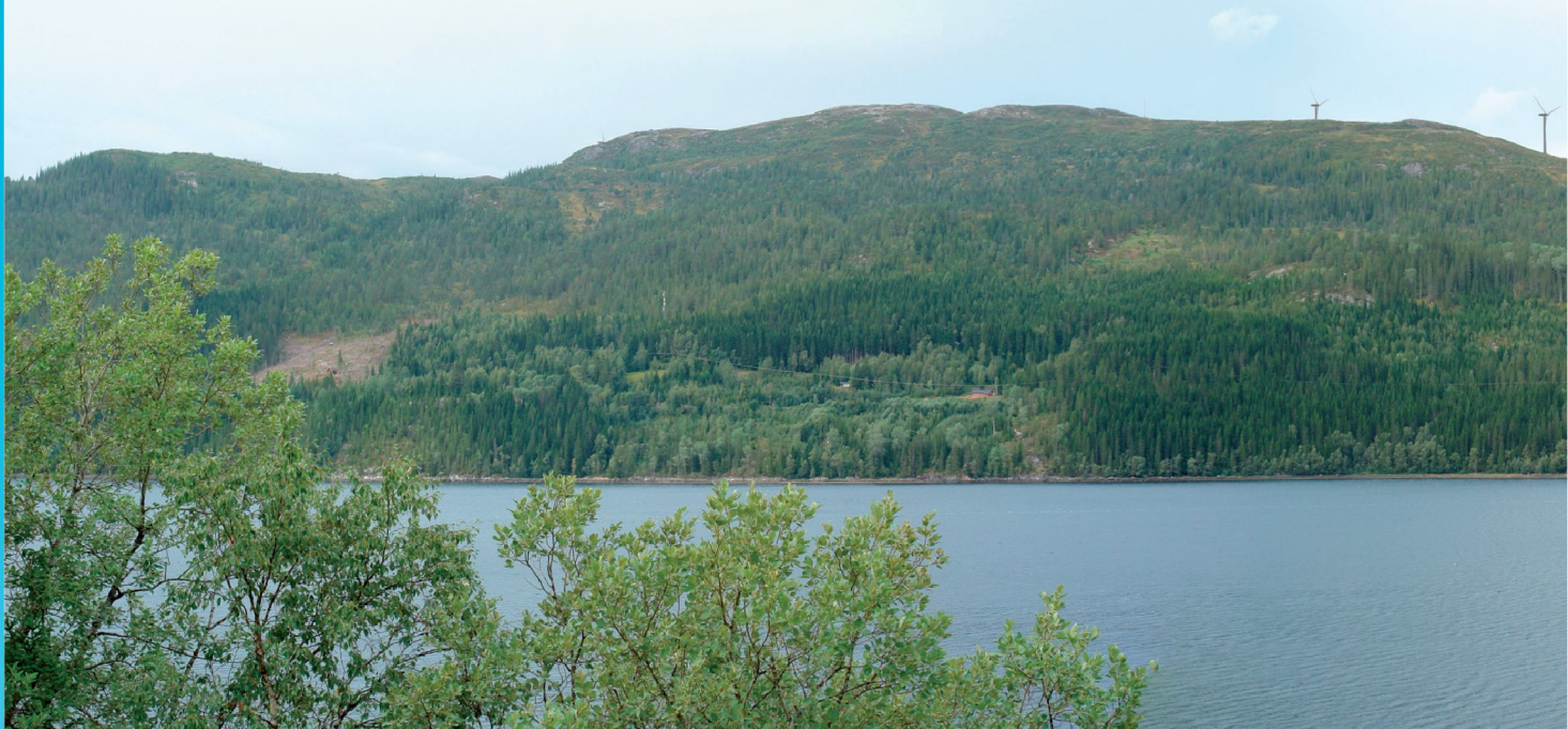
Rapheia vindpark sett fra riksvei 17 ved Leirvik. Foto og visualisering: Sweco
