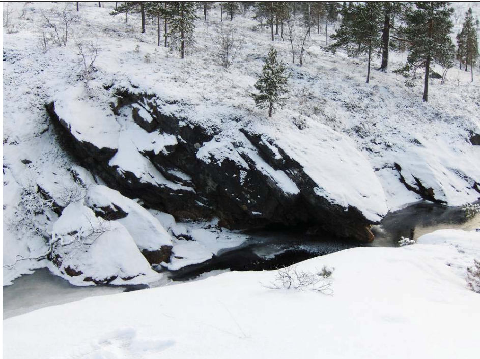
Bilde 3. Selve damstedet/inntaket, i enden av kløft
