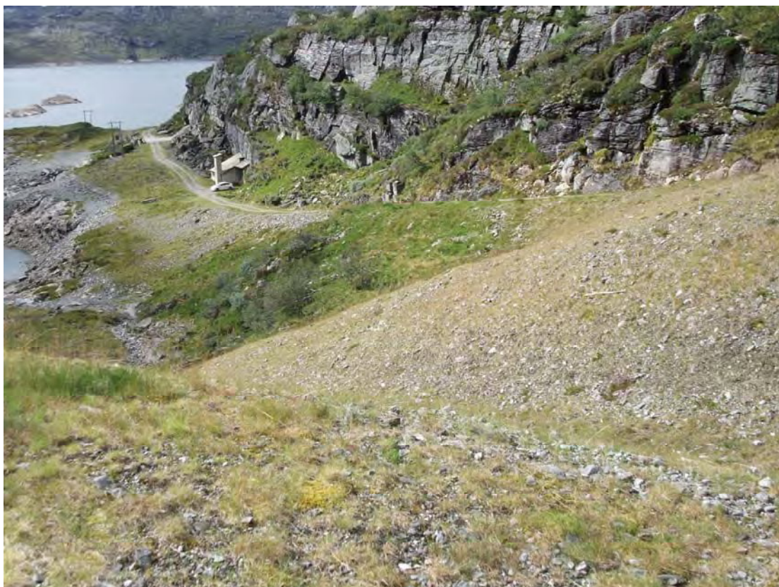
Foto 3 Foto sett fra toppen av eksisterende tipp og ned mot eksisterende lukehus.
