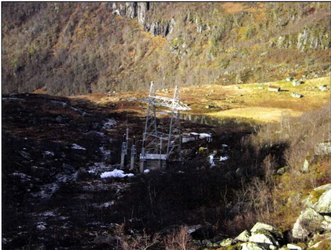
Figur 3.5.2: Eksisterende muffehus/stølsbebyggelse på Krosstølen. Bilde: BKK
