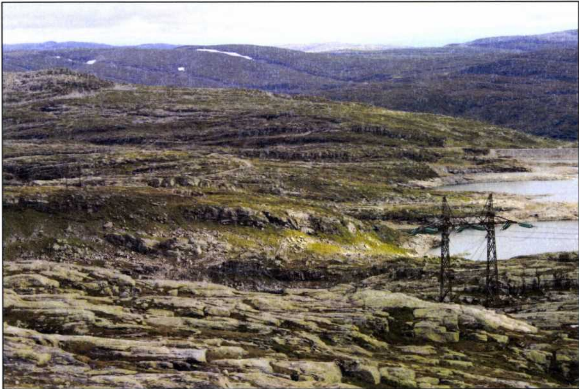
Figur 3.3.6: Utsikt fra Gavlan der vi ser 300 kV ledningen som går øst-sydøstover og passerer like nord for Skjerjevatnet. Dammen i Skjerjevatnet til høyre bak i bildet (bilde fra befaring 23.8.2010).
