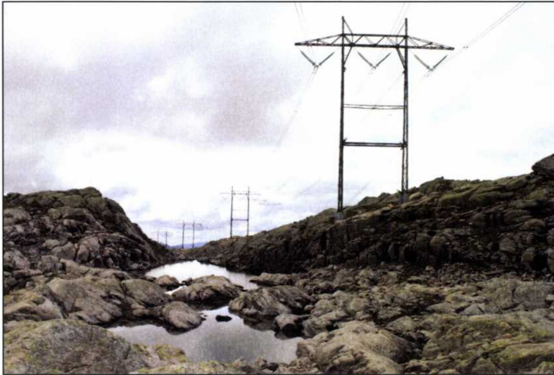
Figur 3.1.5: Gavlafjellet mot Austredalen (bilde fra befarings 23.8.2010).
