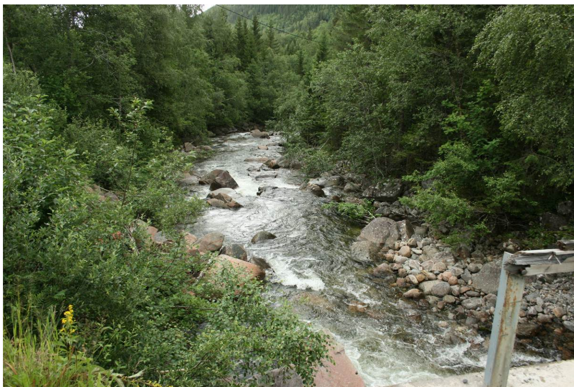
Bilde 1.2 Inntak & nedover
