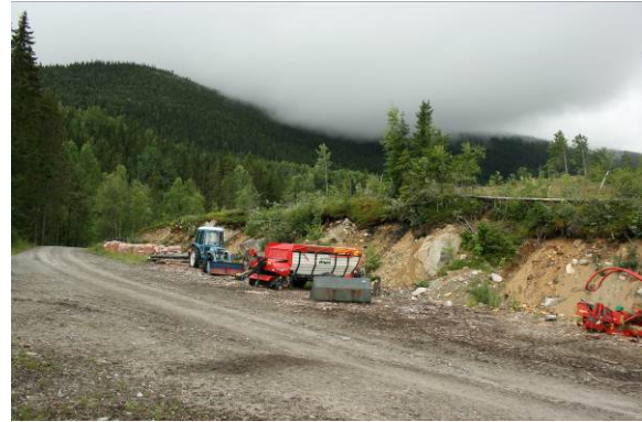
Bilde 3.2 Rørgate igjennom grusgruve
