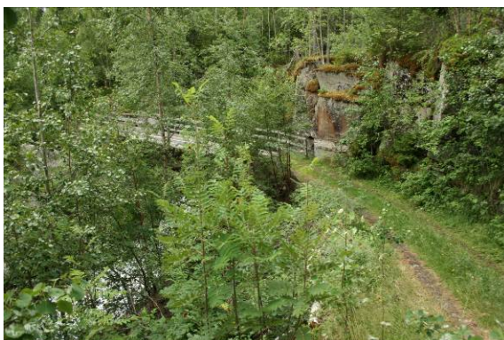
Bilde 3.7 Rørgate nedre vei 2
