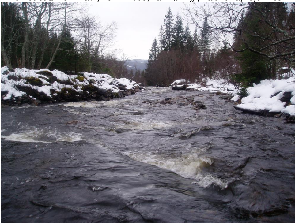
Like nedstrøms inntak, 23.11.2005, vannføring (målt i elva): 0,6 m 3 /s
