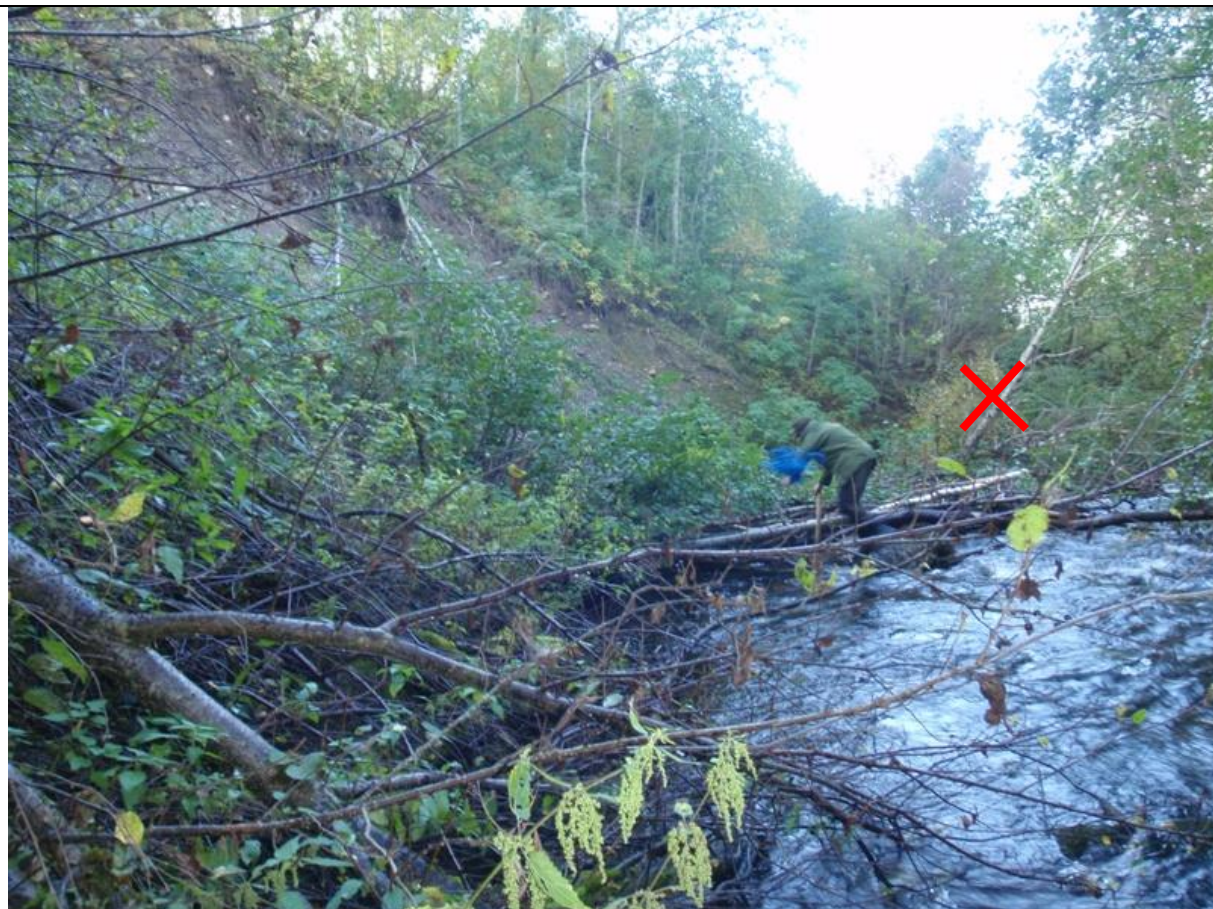
Bilde 14. Kraftstasjonsområdet (22.9.2009). Stasjonen plasseres like bak X.
