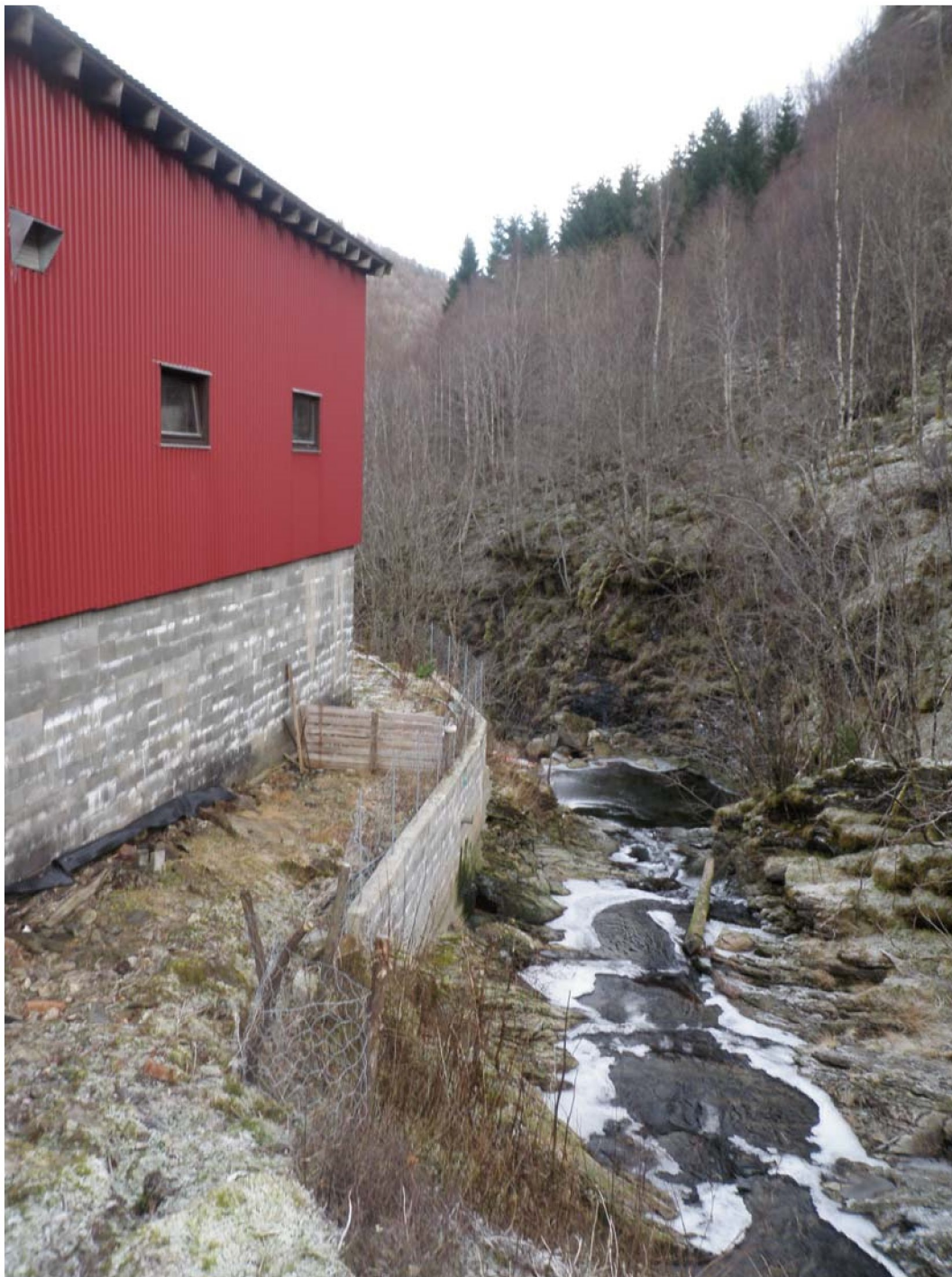
Bildet viser et smalt parti der rørgaten må legges mellom elv og driftsbygning
