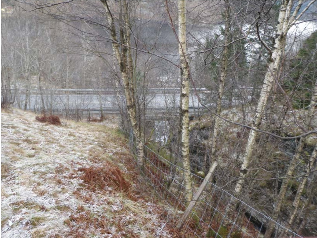
Bildet viser E16 som krysser over Jørnevikelvi
