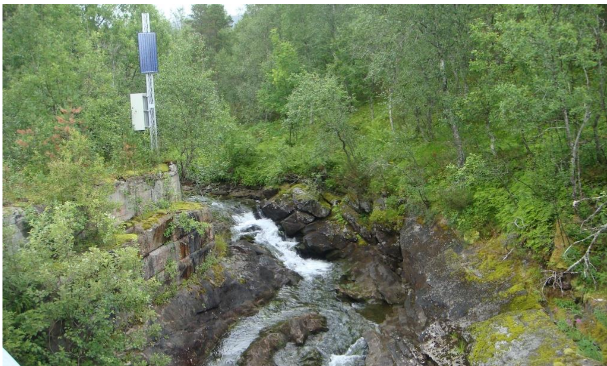
Figur 6. Bildet viser inntaksområdet tett ovenfor der E6 krysser Mørsvikelva. Til venstre står det en målestasjon for vassføring. Målestasjonen vil bli flyttet ihht NVE's anbefalinger. (Foto: Geir Frode Langelo ©).
