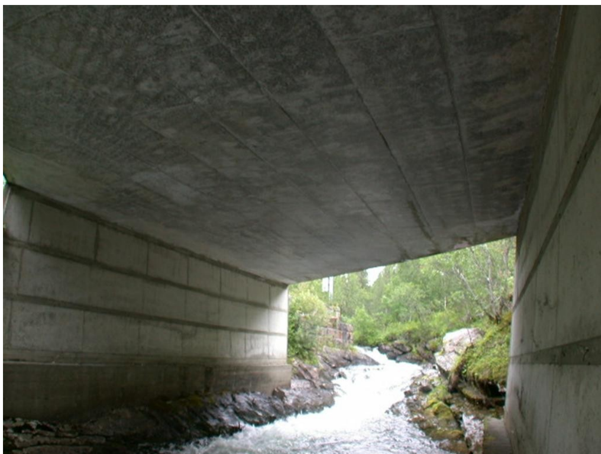
Bilde 5. Bildet er under bru E6. (Foto; Statens vegvesen)
