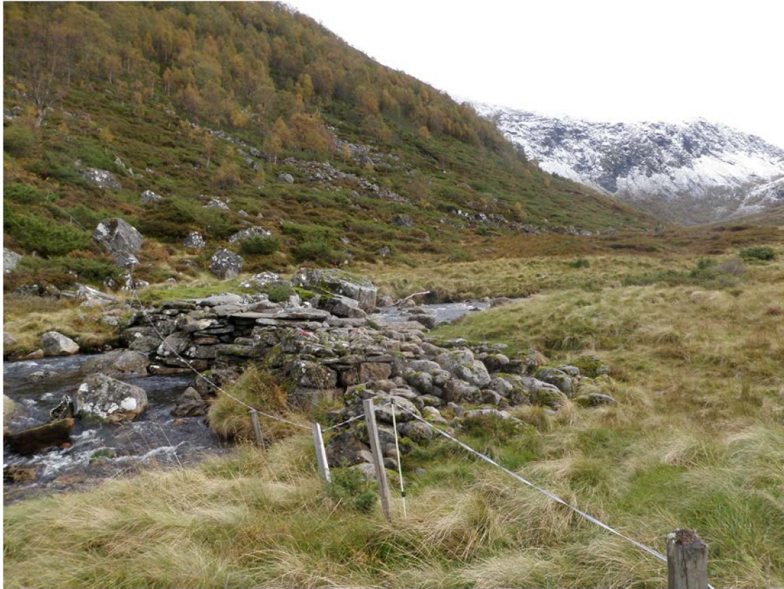
Bildet viser en gammel bro som ligger like nedstrøms inntaket
