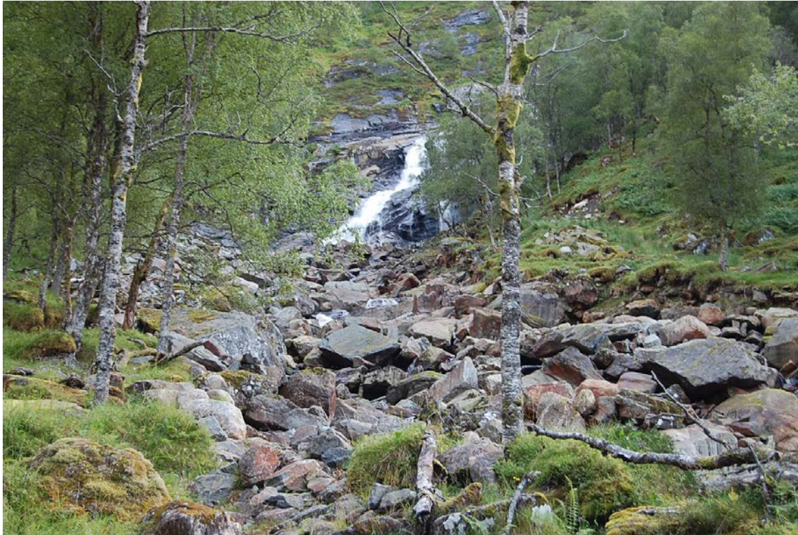
Bildet viser del av rørtrase. Bildet er tatt 23.08.2010. Døgnmiddelvannføring for denne datoen, skalert for vannmerke 96,3 Hareidselv er 0,43 m 3 /s.
