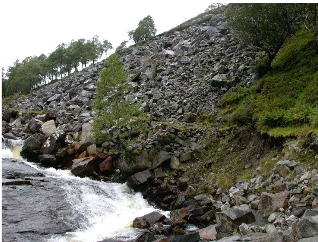
Figur 13.7. Ovenfor Storefossen er et stykke av den gamle veien rasert.
