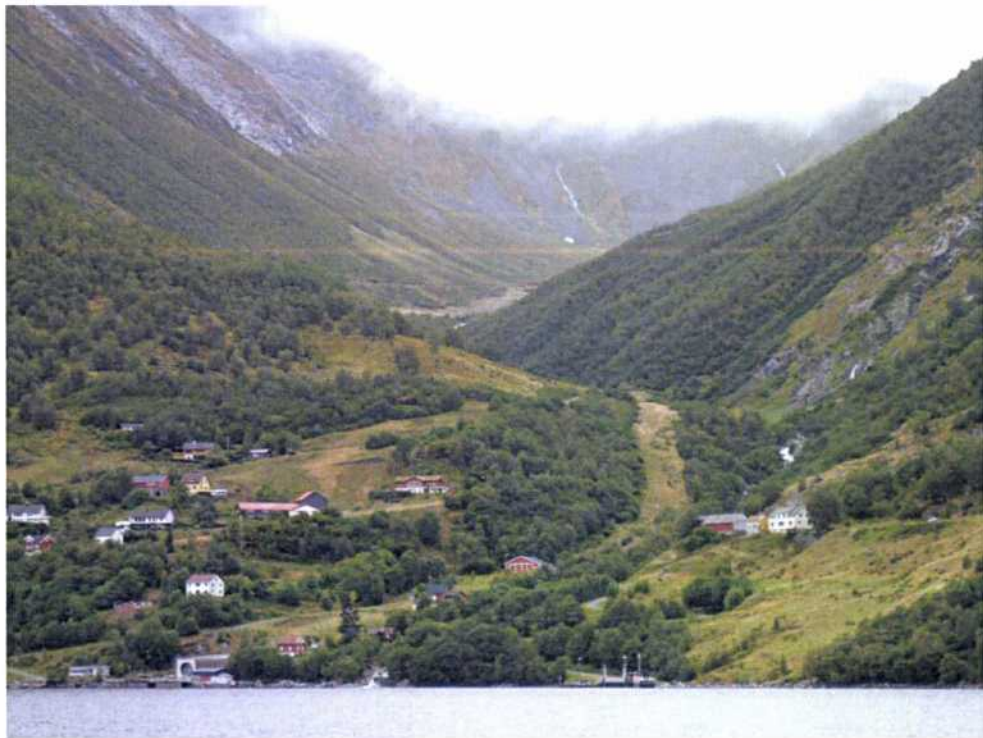
Trandal kraftverk i utredningsområdet ble utbygd og satt i drift i 2005. Rørledningstraséen er fremdeles tydelig i terrenget. Kraftstasjonen er den grå betongbygningen nede ved fjorden, til venstre i bildet.
