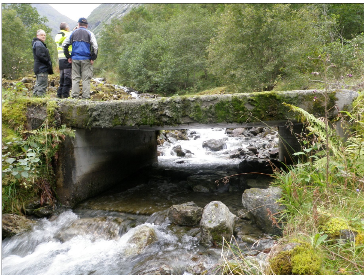
Broen som krysser over Helgåa
