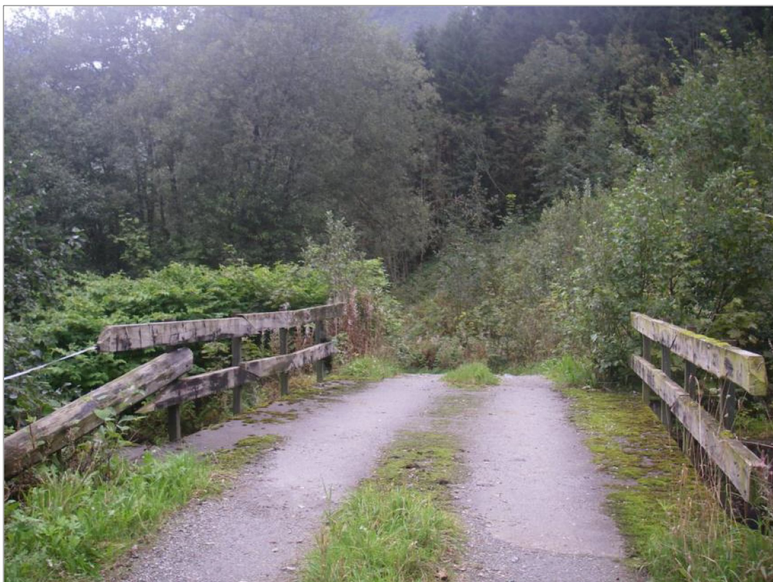
Broen som krysser Holåa like oppstrøms plassering av kraftstasjon
