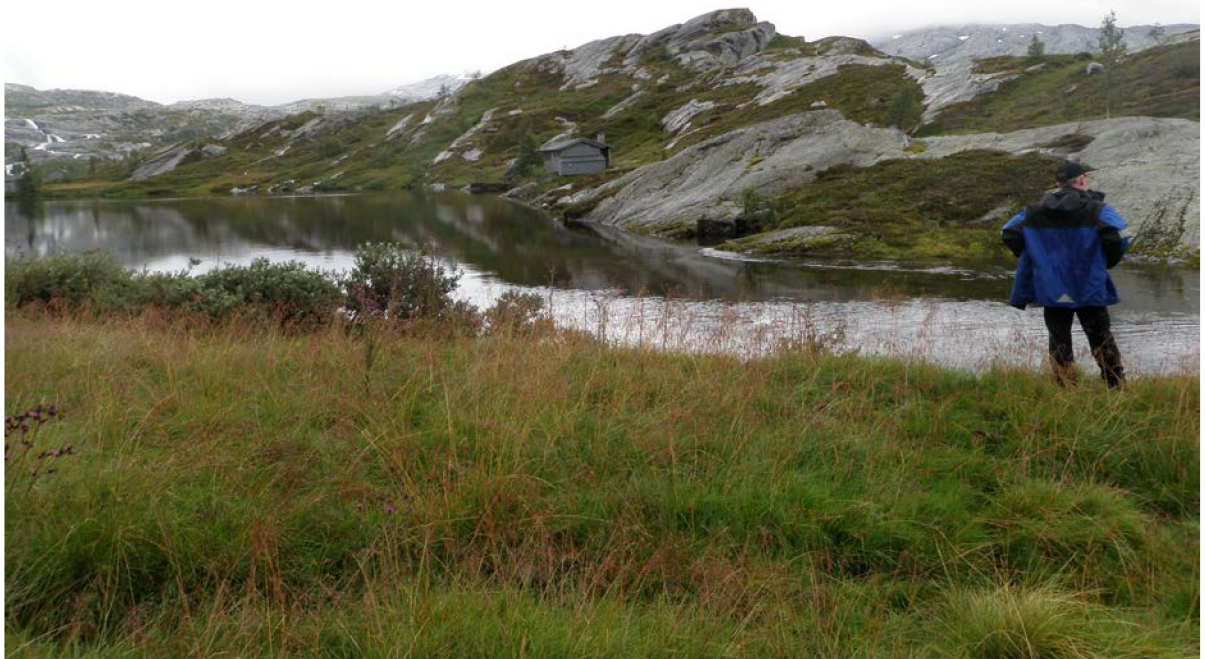
Bildet viser område for plassering av terskel ved Nedre Kumlevatn sitt utløp
