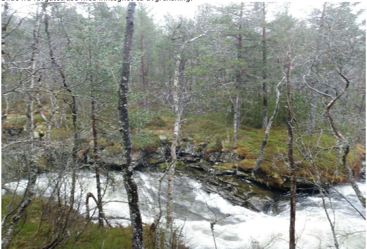
Bilde fra område for kraftstasjonsplassering og brokryssing, tatt fra nordsiden av elven
