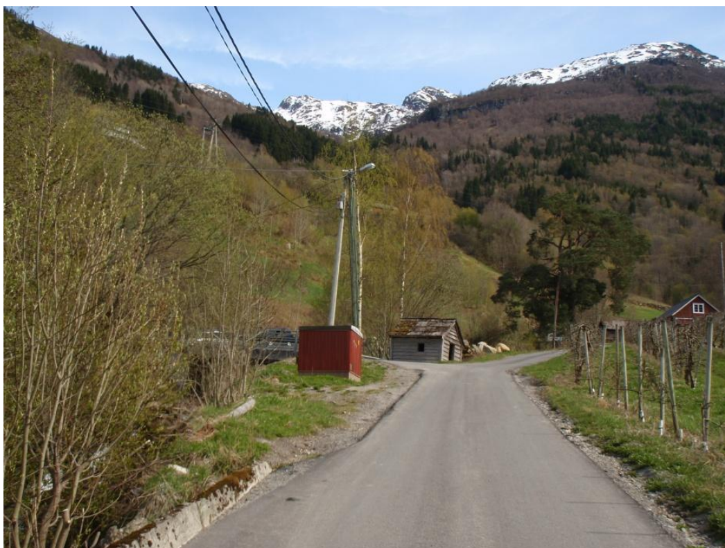
Kraftstasjonsområde til venstre bak trafokiosk og bru
