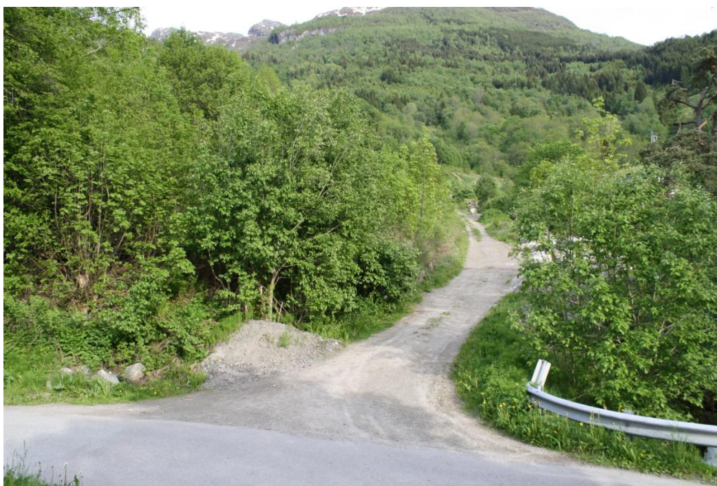
Kraftstasjonsområde. Stasjon til venstre, elv til høyre.
