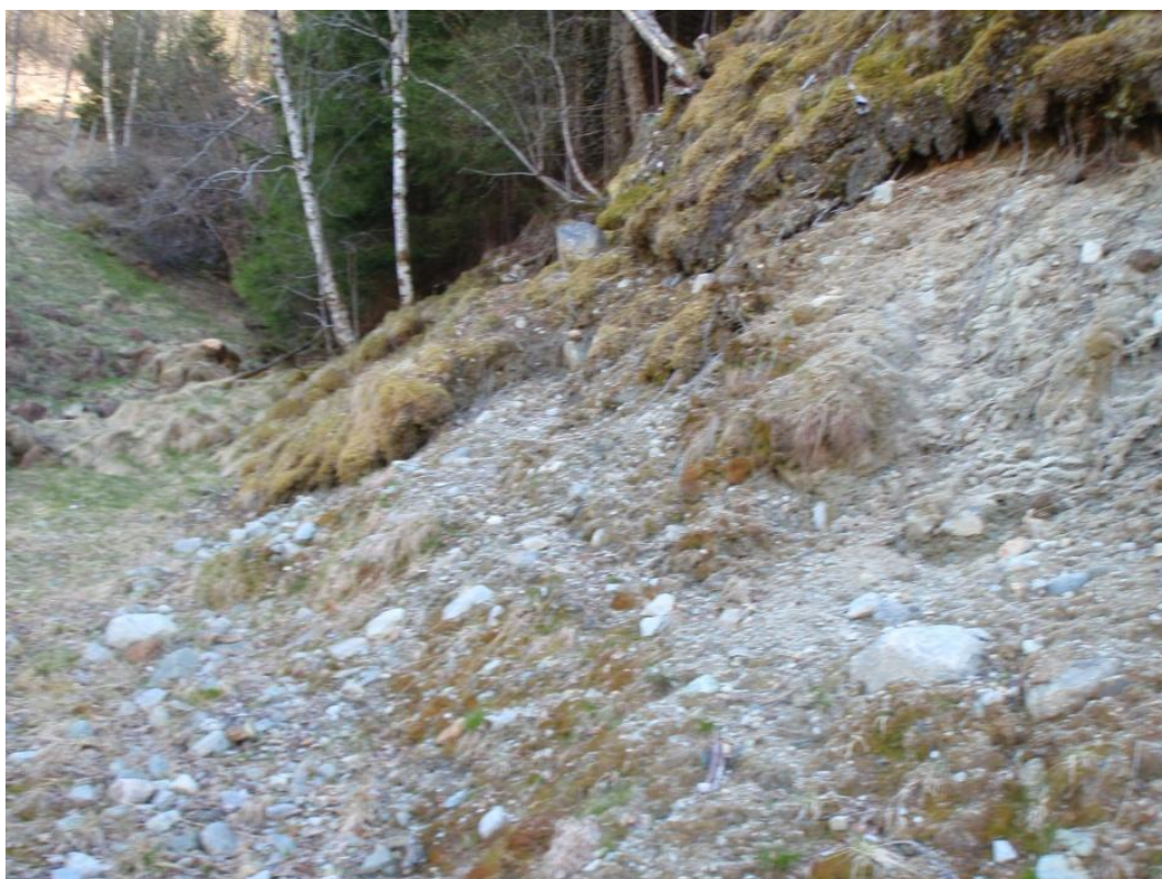
Veiskjæring midtre partier; noe løsmasser
